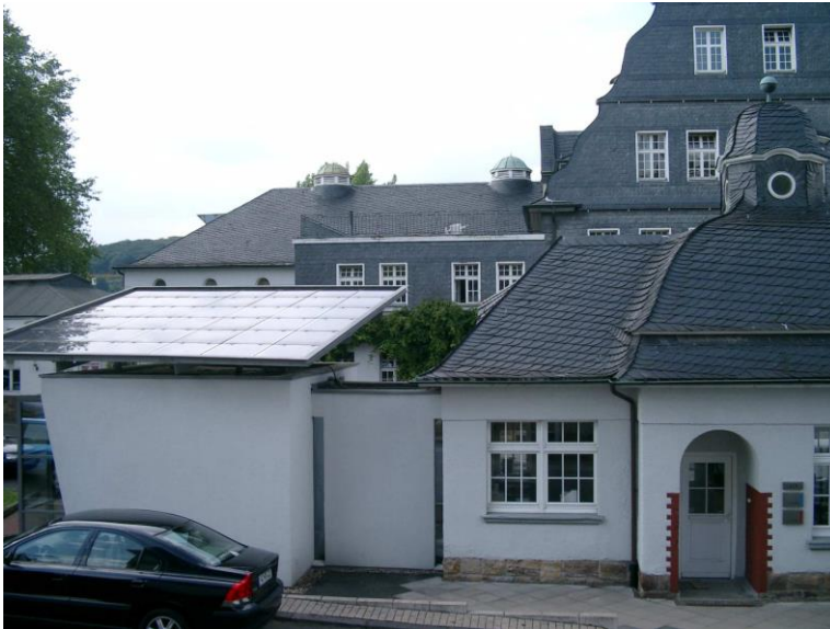
Auf dem modernen Anbau an das neobarocke Pförtnerhaus ist das Photovoltaikdach selbstverständlicher Teil einer gut gestalteten zeitgenössischen Architektur in der unmittelbaren Nachbarschaft des denkmalgeschützten Ensembles. Foto: LVR-ADR
