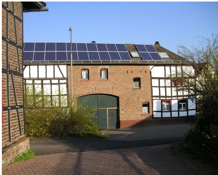
Die Ansicht zeigt deutlich, dass das Dach des Hofgebäudes eine neue Prägung erhält, die sich sehr weit von den charakteristischen Merkmalen der historischen Anlage entfernt und die historische Gestalt stark verfälscht. Foto: LVR-ADR
