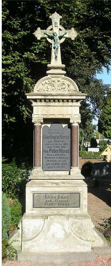
Grabmal aus hellem Sandstein mit Säulen aus rotem Granit und Inschriftplatten aus Schwarz-Schwedisch Basalt. Bedburg, 2006
