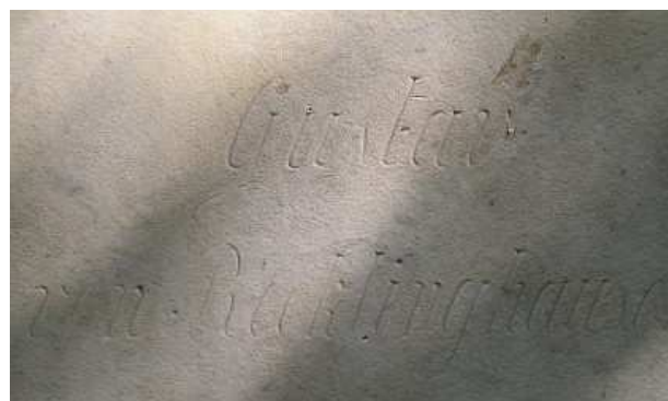
Äußerst fein eingehauene und durch Rückwitterung nicht mehr gut lesbare Inschrift in weißem Marmor. Ein Nachschlagen würde den Charakter der Inschrift völlig zerstören. Köln, Friedhof Melaten, 2009
