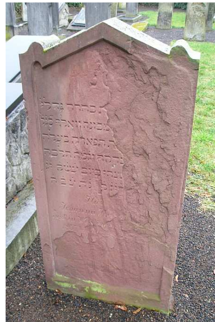
Durch Schalenbildungen verloren gehende Inschrift an einem Grabstein aus rotem Sandstein. Wesseling, jüdischer Friedhof, 2005
