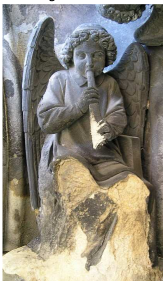
Engelsfigur aus Savonnières-Kalkstein mit schwarzen Gipskrusten. Aachen, Dom, 2005
