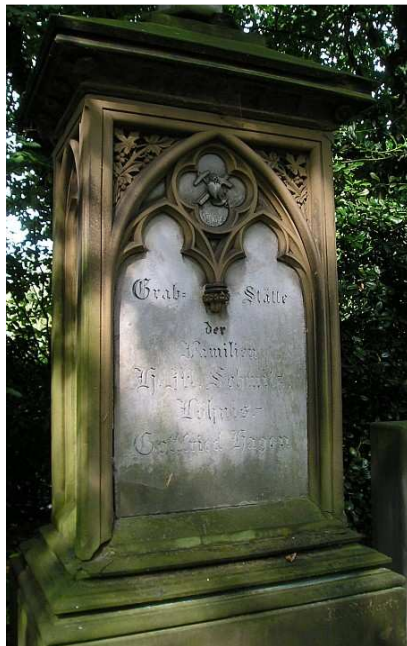
Ehemals dunkel ausgelegte keilförmig vertieft eingehauene Inschrift in einer Platte aus weißem Marmor. Köln, Friedhof Melaten, 2009
