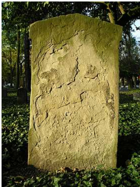
Mehrlagige Schalenbildung an einem Sandstein. Köln, Geusenfriedhof, 2009
