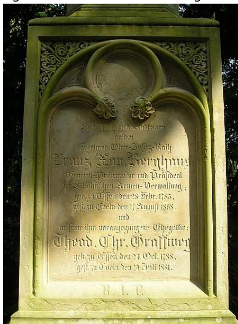
Keilförmig vertieft eingehauene Inschrift in hellbraunem Sandstein (Heilbronner?), im Streiflicht ausgezeichnet lesbar. Eine farbige Auslegung wäre hier fehl am Platze. Köln, Friedhof Melaten, 2009
