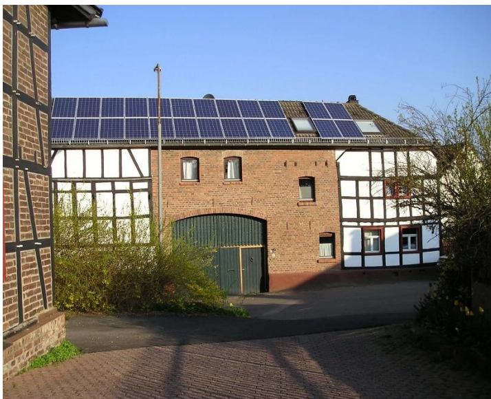
Die Ansicht zeigt deutlich, dass das Dach des Hofgebäudes eine neue Prägung erhält, die sich sehr weit von den charakteristischen Merkmalen der historischen Anlage entfernt und die historische Gestalt stark verfälscht. Foto: LVR-ADR
