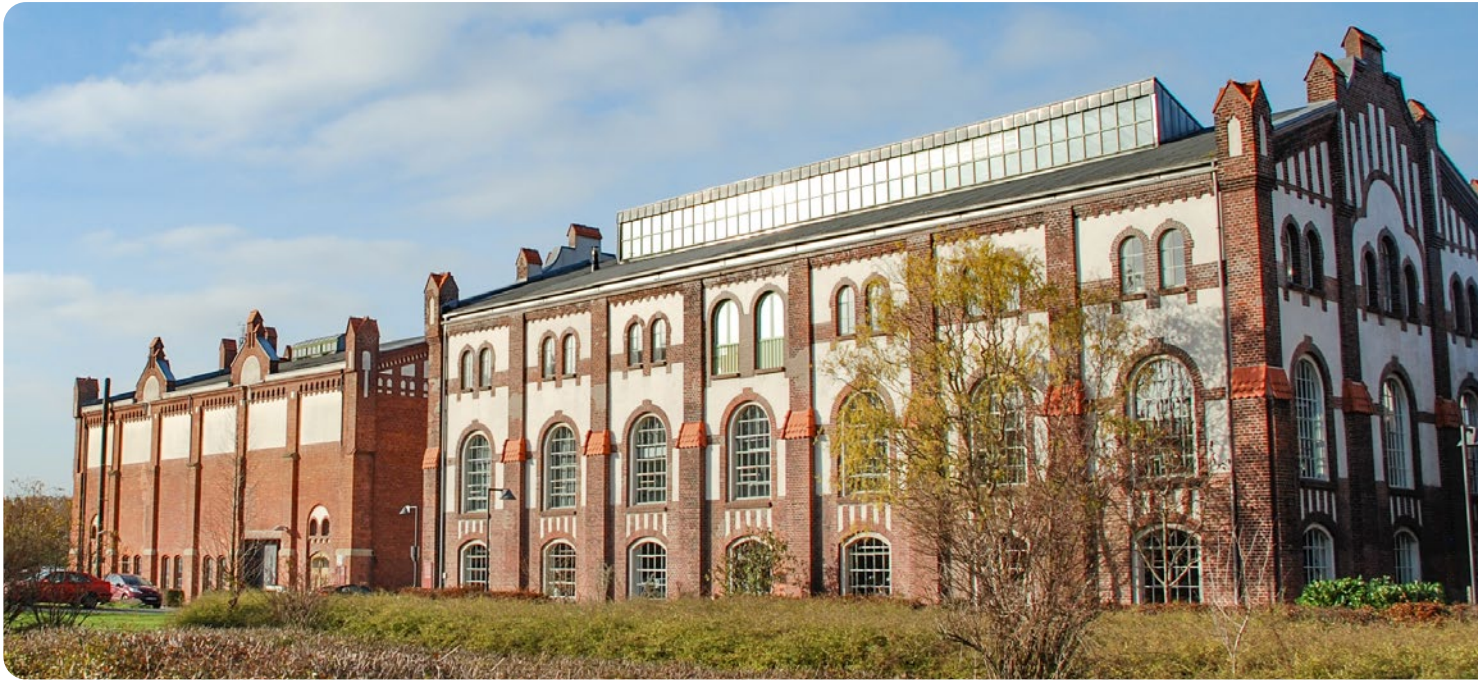
Bild 52: Zeche Waltrop, Waltrop
