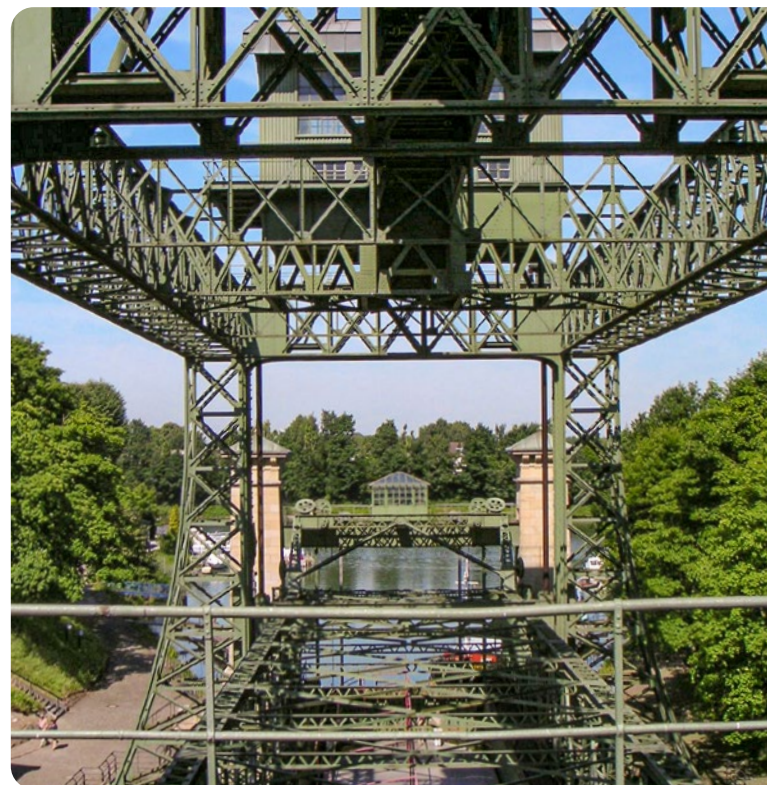
Bild 36: Altes Schiffshebewerk Henrichenburg am Dortmund-Ems-Kanal, Waltrop
