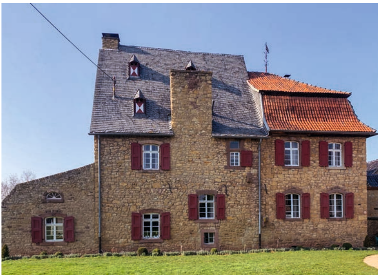
18. Historisches Dach eines Burghauses mit Schiefer- und Ziegelflächen, Aufbauten, Öffnungen und Kaminen. Foto: R. Mohr, UDB Zülpich, 2022.
