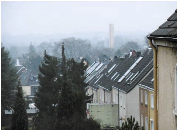
4. Mülheim/Ruhr, Siedlung Heimat- erde, Thermosolar rückwärtig. Foto: Stadt Mülheim/Ruhr, Untere Denkmal- behörde (UDB).
