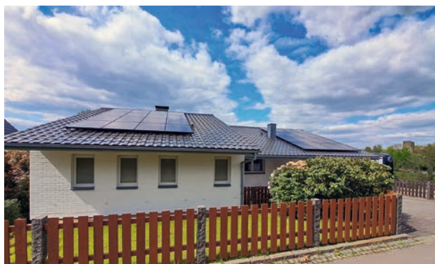
7. Blankenberg, Photovoltaikanlage Im Früngt. Foto: UDB Hennef, 2024.
