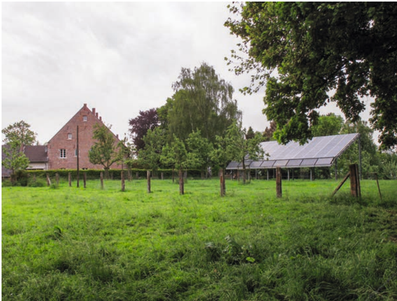
17. Freistehend aufgeständerte Solaranlage in der Nachbarschaft einer Hofanlage. Foto: Dimitrij Davydov, LVR-ADR, 2009.
