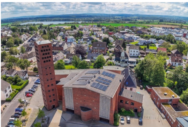
12. Mit PV-Modulen bedecktes Flachdach eines Wohnhauses, Straßenansicht und Dachaufsicht. Foto: E. Westerhoff, UDB Viersen, 2022.
