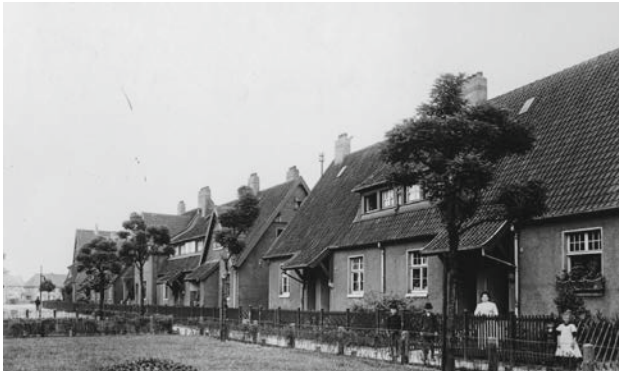
8. Historisches Foto der Häuser an der Eisenstraße in der Margarethen-Siedlung in Duisburg-Rheinhausen. Quelle: Stadtarchiv Duisburg.
