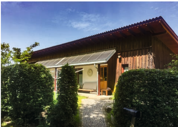
9. Als Vordach einer Scheune, in einer tiefer liegenden Ebene integrierte Solaranlage. Foto: Claudia Euskirchen, LVR-ADR, 2022.
