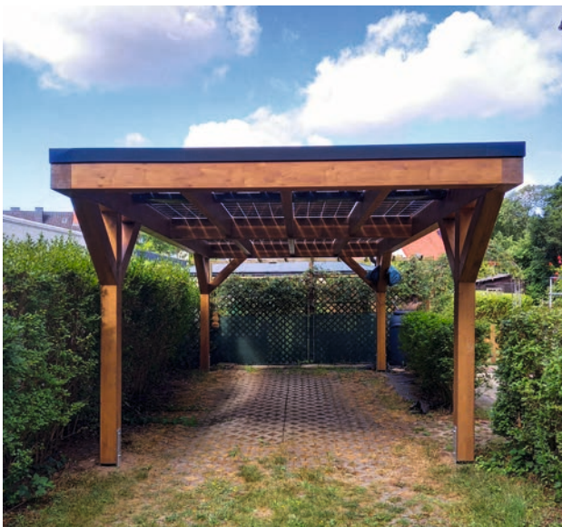
4. Beispiel eines Solar-Carports, Siedlung Duisburg-Bissingheim. Foto: UDB Duisburg.
