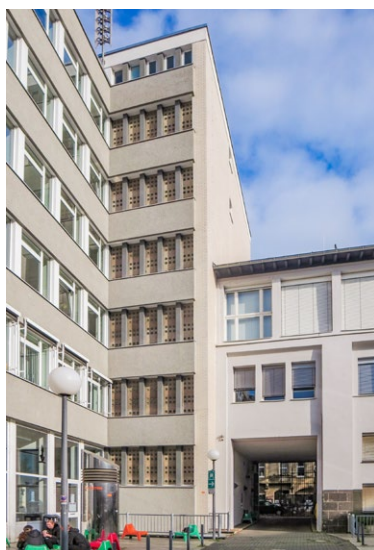
8. Nachkriegsneubau zum Innenhof, nach Wärmedämmung neu verputzt, 2015. Foto: Petra Sophia Zimmermann.
