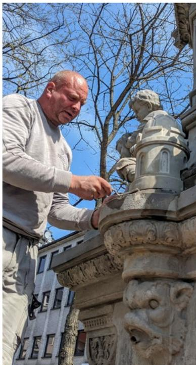
6./7. Köln, Hermann-Joseph-Brunnen. Für die Rekonstruktion wurde zunächst ein Modell aus Ton gefertigt, um die Größe und die Proportionen festzulegen (links); das fertige Türmchen aus Obernkirchner Sandstein wurde rückseitig angepasst und montiert (rechts).
