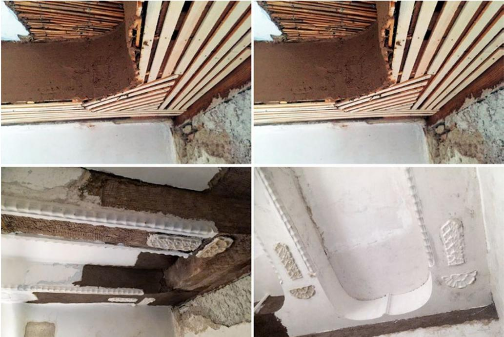
Die Putzträger-Lattung wurde wie fehlend mit eigens zugeschnittenen Spalierlättchen ergänzt, dann Lehmputz mit Stroh-Häckseln gut in die Putzträger-Lattung durchgedrückt. Die ausgebauten Rosetten und Ranken wurden wieder eingebaut, übrige fehlende Stuckaturen aus Gips gegossen und eingebaut, abschließend Gips-Kalk-Mörtel angerührt, aufgezo-gen und geglättet.
