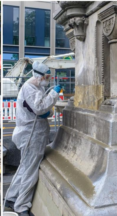
nem Großteil ausgebrochen und verwittert. Zudem waren durch das stark kalkhaltige Wasser der Kölner Innenstadt im Spritzbereich und Ablaufbereich der Wasserbecken Kalksinterkrusten entstanden, die unterhalb der Becken bis zu 15 mm dicke Auflagen bildeten.
