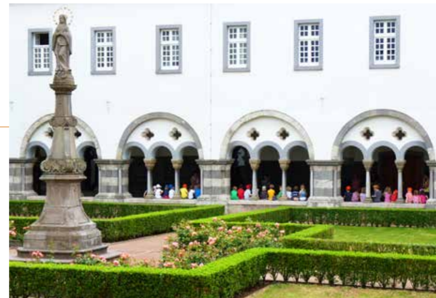
Abtei Brauweiler, Marienhof und Kreuzgang, Kinderführung
