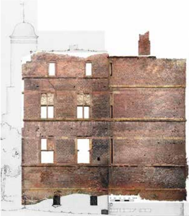
TLS: Auf einem Hochstativ oder mit einer Drohne erhebt sich die Digi-Cam in die Lüfte und liefert Aufnahmen aus fast jeder Perspektive. Auch die Auflösung des Systems ist bei hohen oder entfernten Objekten mit SfM homogener: Während die TLS-Auflösung mit größerer Entfernung und hohen Visuren abnimmt, bietet SfM mit einer objektnahen Kameraführung beste Reserven.
