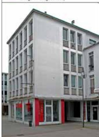
Positives Beispiel Fassade - Konstruktion: Instandgesetzte Stahlbetonskelettfassade mit ornamental gestalteten Ausfachungen. Hauptstraße 30 (negativ: zu umfangreiche Werbeanlage)
