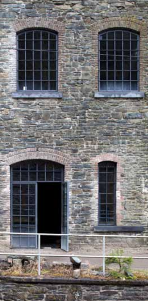
Monschau-Dreistegen, ehem. Scheiblersche Textilfabrik.
