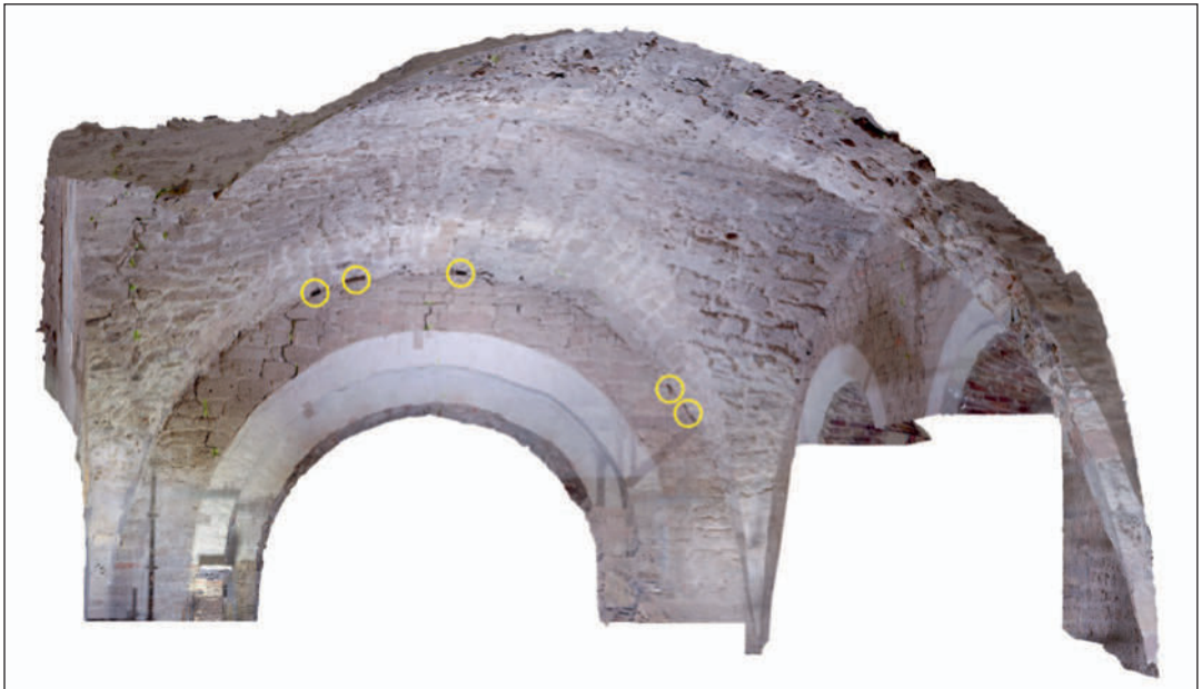
4 | 3D-Vermessung des Gewölbes, Blick nach Osten. Die Kreise kennzeichnen offenliegende Befundstellen mit Resten der Schalbretter oder deren Abdrücke im Mörtelbett. Vermessung: Hans Meyer, LVR-ADR, 2021.
