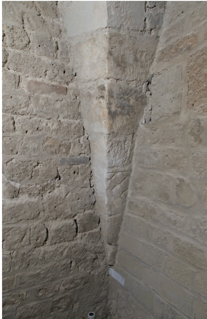
3 | Gewölbeanfänger der Südostecke des südlichen Querarms aus aufeinander gestapelten Kleinquadern mit zweitverwendetem Ornamentquaderstück aus lothringischem Kalkstein. Foto: Hans Brauer, LVR-ADR, 2021.
