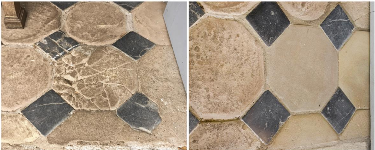
ABBILDUNG 2: ZUSTAND DER BODENPLATTEN VOR UND NACH DER RESTAURIERUNG DURCH DIE FA. PAPE, NEUNKIRCHEN-SEELSCHEID (FOTOS: CHRISTOPH SCHAAB, LVR-ADR, 2019 (LI.); JONAS DETEMPLE, BLB-NRW, 2020 (RE.))
