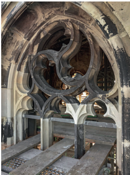
ABBILDUNG 3: REPARATUR VON AUSBRÜCHEN AM NÖRDLICHEN MAßWERK DES TURMOBERGESCHOSSES MITTELS VIERUNGEN AUS SANDSTEIN (FOTO: CHRISTOPH SCHAAB, LVR-ADR)
