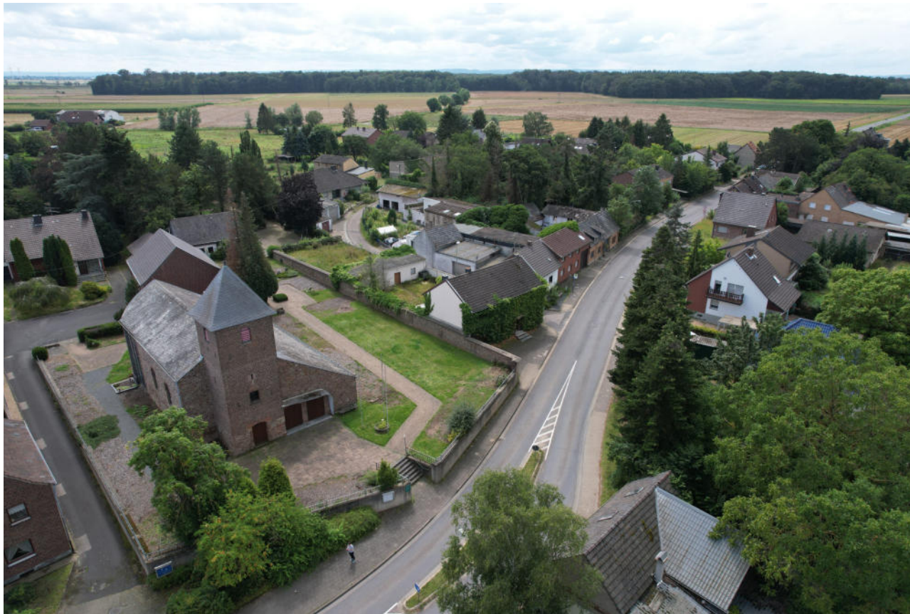
Abb. 1: Blick über die Ellener Straße von der Dorfmitte in Richtung Südwesten, 2021.
