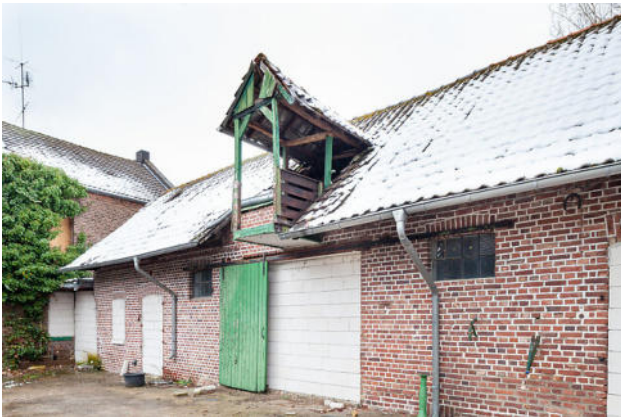
Abb. 11: Stall-/Lagergebäude im Hof an der Oberstraße 29, 2021.
