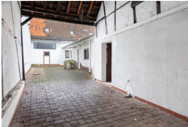
Abb. 13: Blick in den Hofraum an der Oberstraße 25, 2021.
