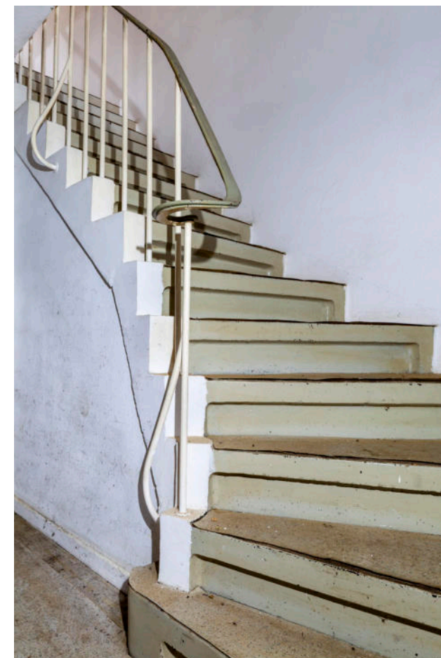
Abb. 28: Bauzeitliche Treppenanlage im Erdgeschoss, 2021.
