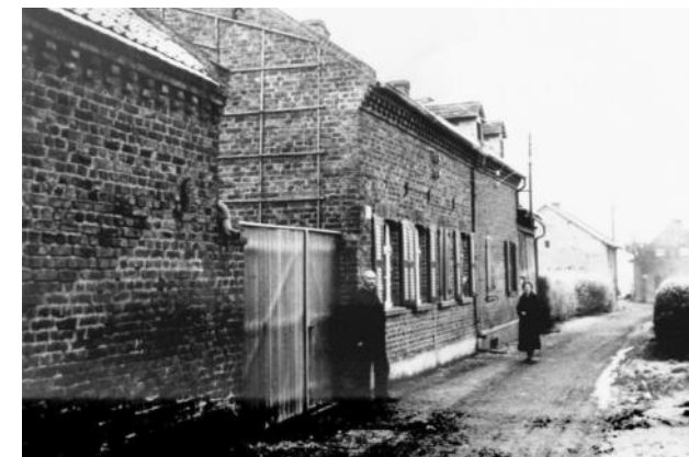
Abb. 8: Hofanlage am Bergfeldchen 4, 1939.
