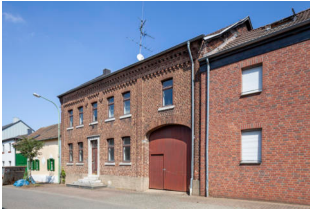
Abb. 10: Repräsentatives Wohnhaus in der Oberstraße 29 (Bautyp 2), 2021.
