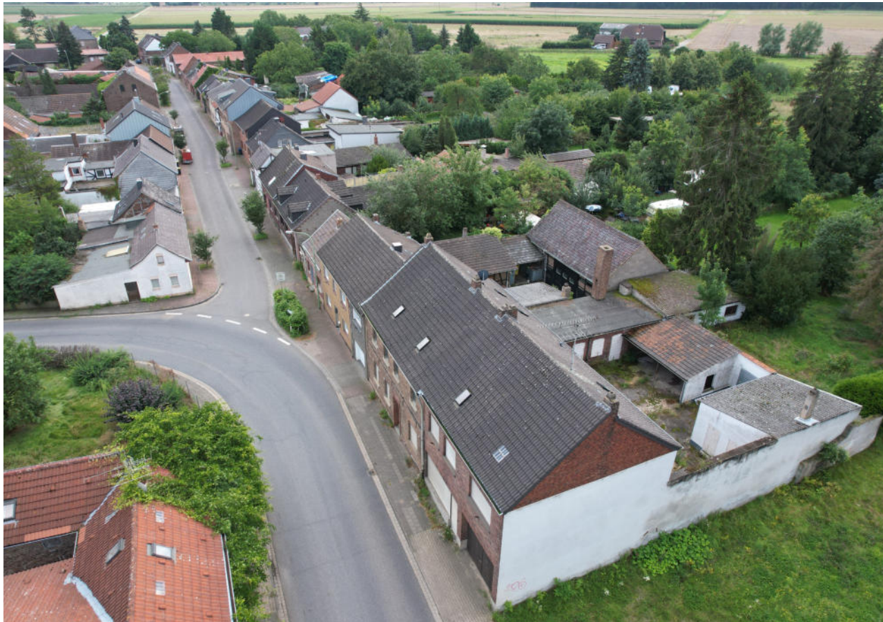
Abb. 1: Blick über die Oberstraße in Richtung Süden, 2021.
