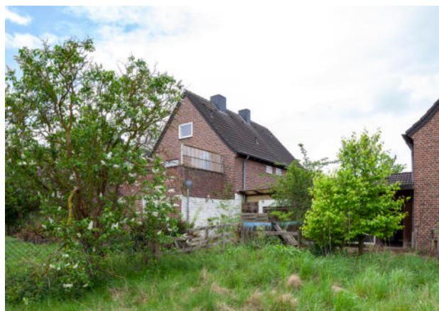
Abb. 27: Rückwärtige Ansicht mit Garten und angebauten Terrassen, 2021.
