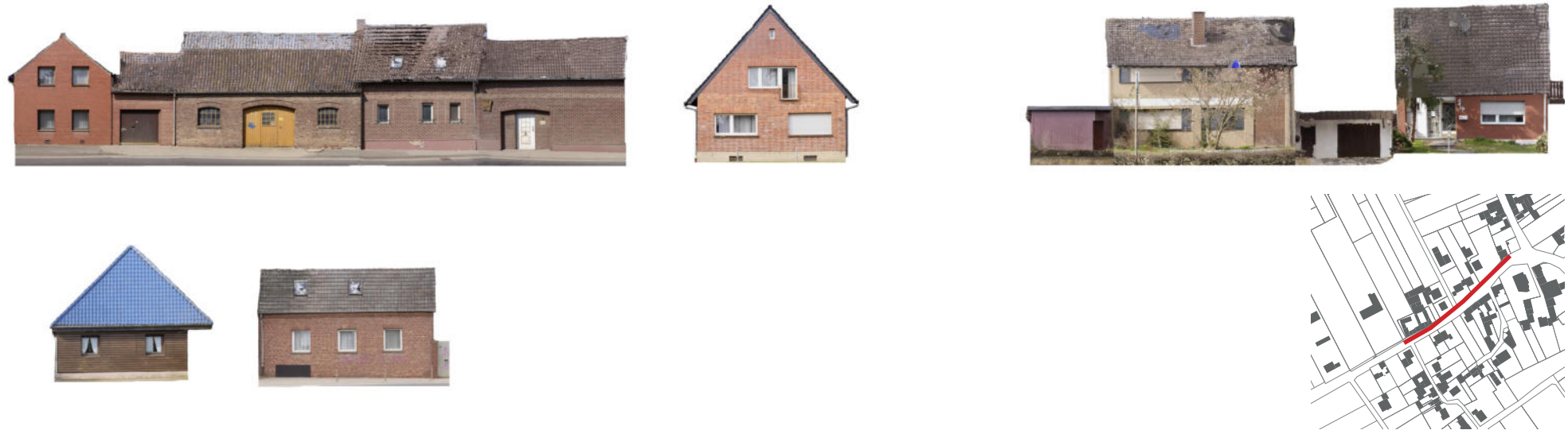
Abb. 11: Fassadenabwicklung der Ellener Straße, gerade Hausnummern (Nordseite) (Abstände der Häuser zueinander nicht maßstäblich), Dächer teilweise mit Fehlstellen bedingt durch die Aufnahmetechnik, 2021.
