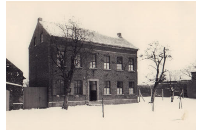
Abb. 11: Schulbau von 1852 in der Oberstraße 13, 1. Hälfte 20. Jhd.
