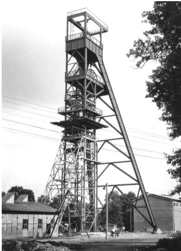
Abb. 4: Fördereturm der zweiten Schachtanlage des Braunkohlentiefbauwerks „Union 103“, 1954.
