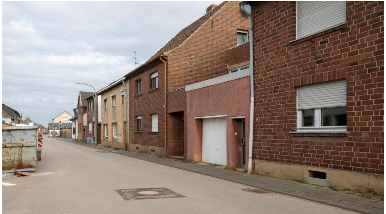
Abb. 4: Nach dem Zweiten Weltkrieg wiederaufgebaute Häuser in der Unterstraße 8–20, 2021.
