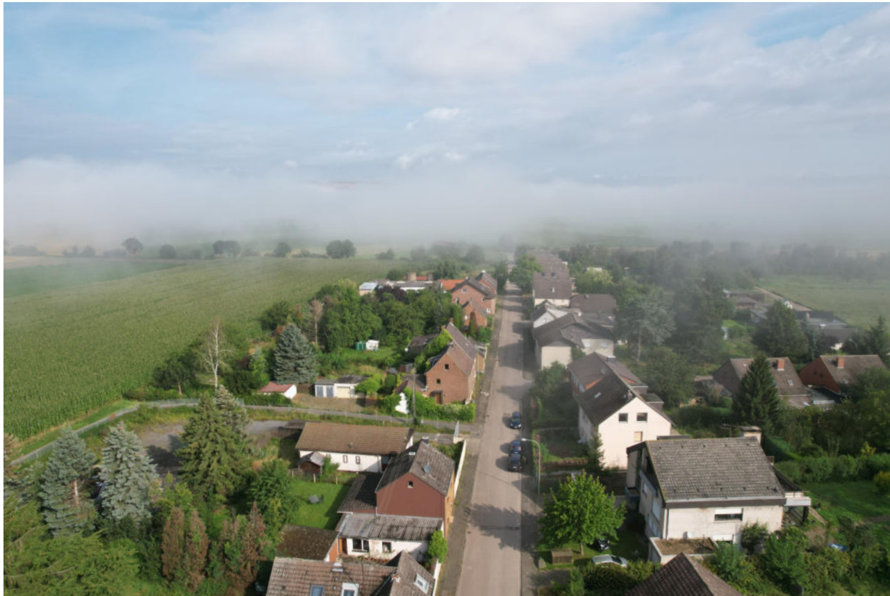
Abb. 1: Blick über die Unterstraße in Richtung Norden, 2021.
