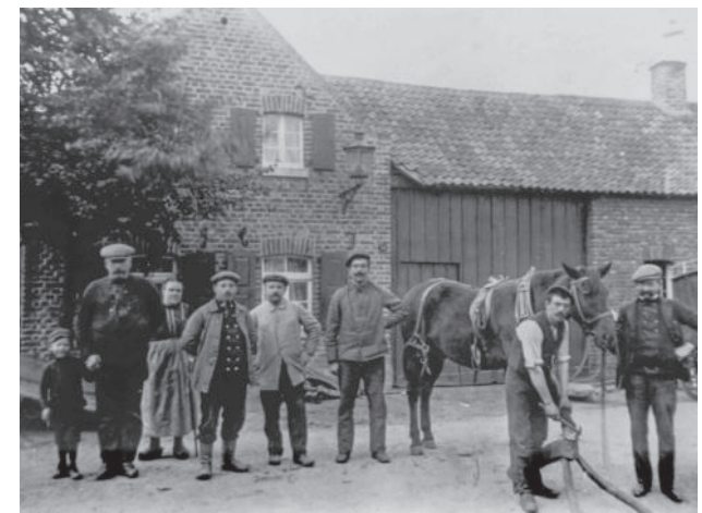
Abb. 6: Hofanlage Ellener Straße 24 (Schmiede), 1921.
