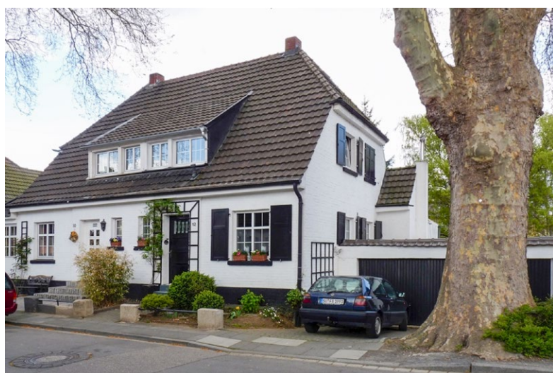
8. Troisdorf, Denkmalsbereich Schwarze Kolonie, Arbeiterwohnhaus an der Lürmannstraße, 1912–14. Quelle: Stadt Troisdorf.
