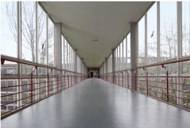
schonendes Überarbeiten der Beschichtung erfolgen durfte: weder die verzinkte Stahloberfläche noch die originale Erstbeschichtung durften mechanisch verletzt werden.
