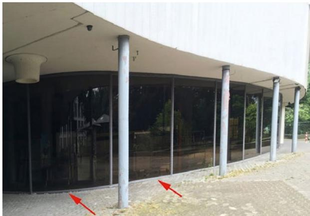
angedachte Komplettaustausch wurde auf eine rein malerische Überarbeitung minimiert: Die Stahlrahmenprofile erhielten „nur“ eine neue Deckbeschichtung. Abschließend ist noch einmal zu betonen:
