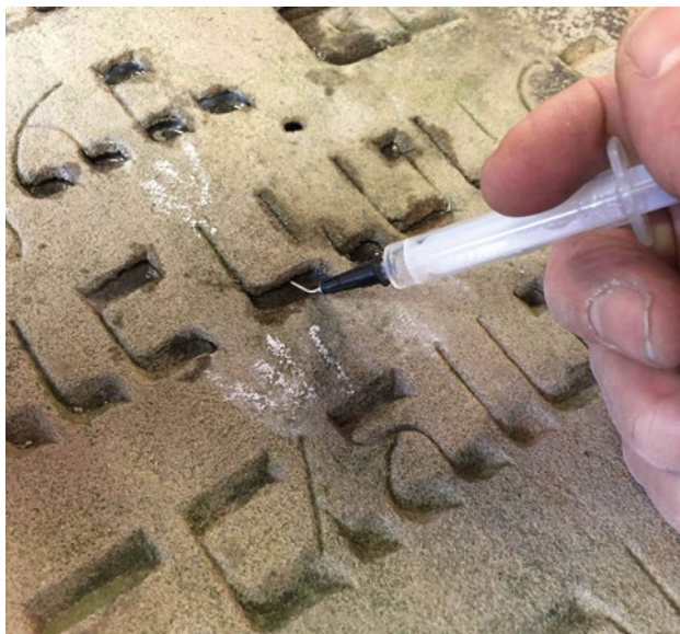
7. Mit Spritzen wird flüssiger Epoxidharz in die losen Schriftflächen eingefüllt. Foto: Manfred Messing, Kempen.
