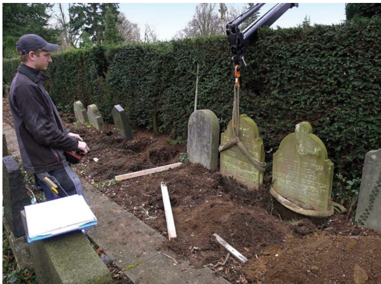
3. Vorsichtiges Herausziehen eines Grabsteins mit weichen Gurtbändern auf dem jüdischen Friedhof in Dinslaken. Foto: Manfred Messing, Kempen.
