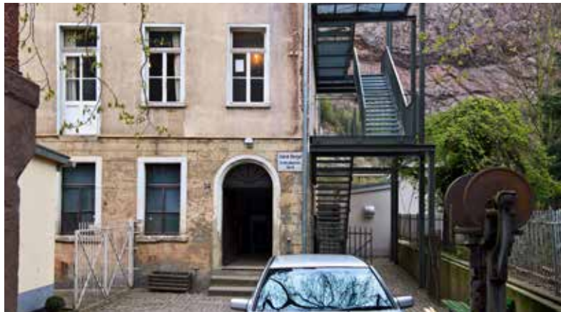
6. Idar-Oberstein, Kettenfabrik Bengel, Industriedenkmal. Foto: Sarah Hutt, Köln.
