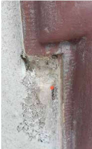
2. Kall-Steinfeld, Kloster. Putzbefunde mit Begleitstreifen am Mittelteil. Foto: Monika Herzog, LVR-ADR.
