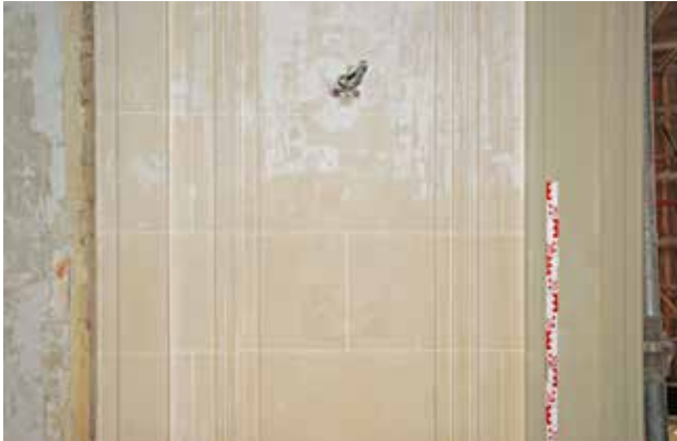
12. Köln, Villa Oppenheim, zentrale Halle, Detail des Kunststein-Putzes. Foto: Forschung am Bau, 2018.
