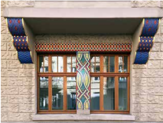
5. Köln-Südstadt, Maria-Hilf-Straße, Fassadendetail. Foto: Jacky Beumling, TH Köln.
