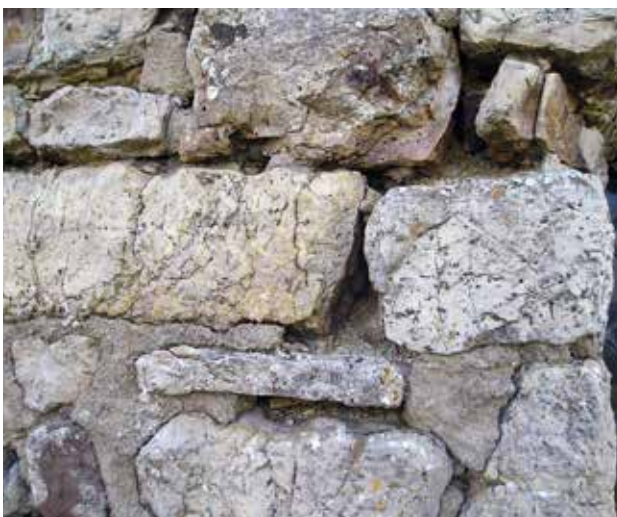
3. Kall-Steinfeld, Kloster m. Basilika St. Potentinus. Schaden- sbild Westfas- sade. Foto: Monika Herzog, LVR-ADR.
