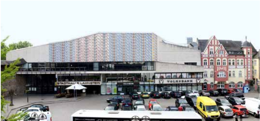
4. Stadthalle Lahnstein, Betonfassade mit künstlerischer Gestaltung. Die farbig gestalteten Elemente sind stark verblasst. Foto: Karoline Sankowski.
