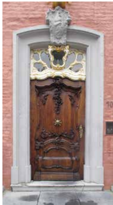
9. Monschau, Rotes Haus. Eingangstür „Zum Goldhelm“, Zustand nach Restaurierung, Frühjahr 2018.
