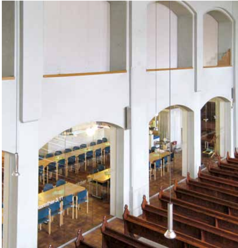
2. Gelsenkirchen-Bismarck, Christuskirche, Einbau Gemeindesaal. Foto: Stadt Gelsenkirchen, UDB.
