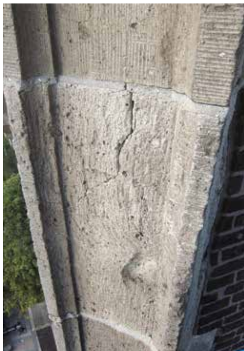
6. Krefeld, Grundlagenermittlung Bauunterhaltung Heilige Schutzengel. Foto: Bistum Aachen.
