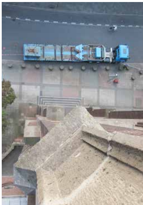
5. Krefeld, Grundlagenermittlung Bauunterhaltung Heilige Schutzengel. Foto: Bistum Aachen.
