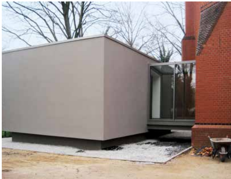
3. Gelsenkirchen-Bismarck, Christuskirche, Anbau Sanitäranlage. Foto: Stadt Gelsenkirchen, UDB.
