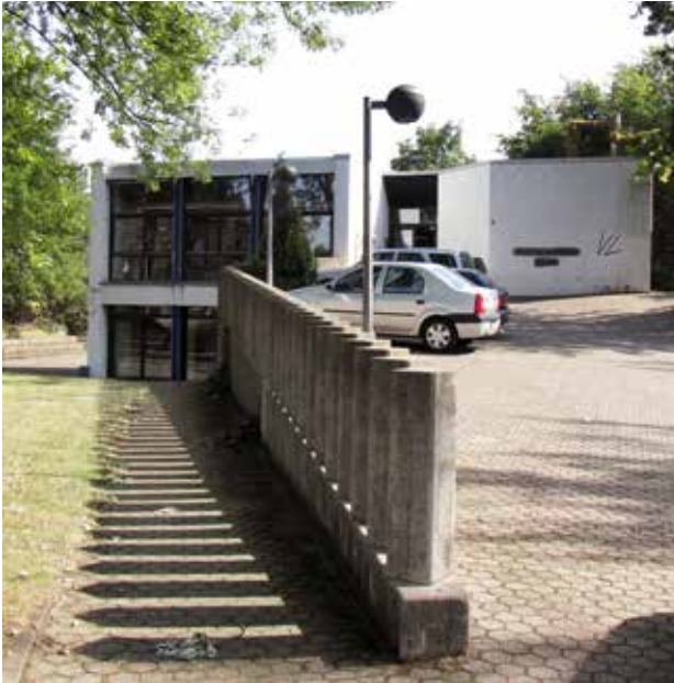
7. Düren-Birkendorf, ev. Gemeindezentrum, Friedenskirche, 1971–73, Architekt: Helmut Striffler. Foto: Stefanie Lieb, 2009.
