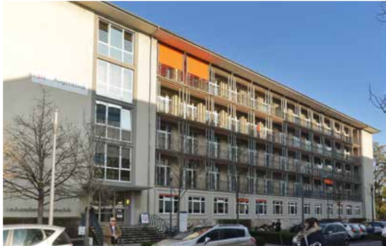
2. Fassade der Augenklinik der Universitätskliniken Köln mit Loggien, Stahlsäulen und Stahlgeländer vor der Sanierung. Foto: Susanne Conrad, LVR-ADR.
