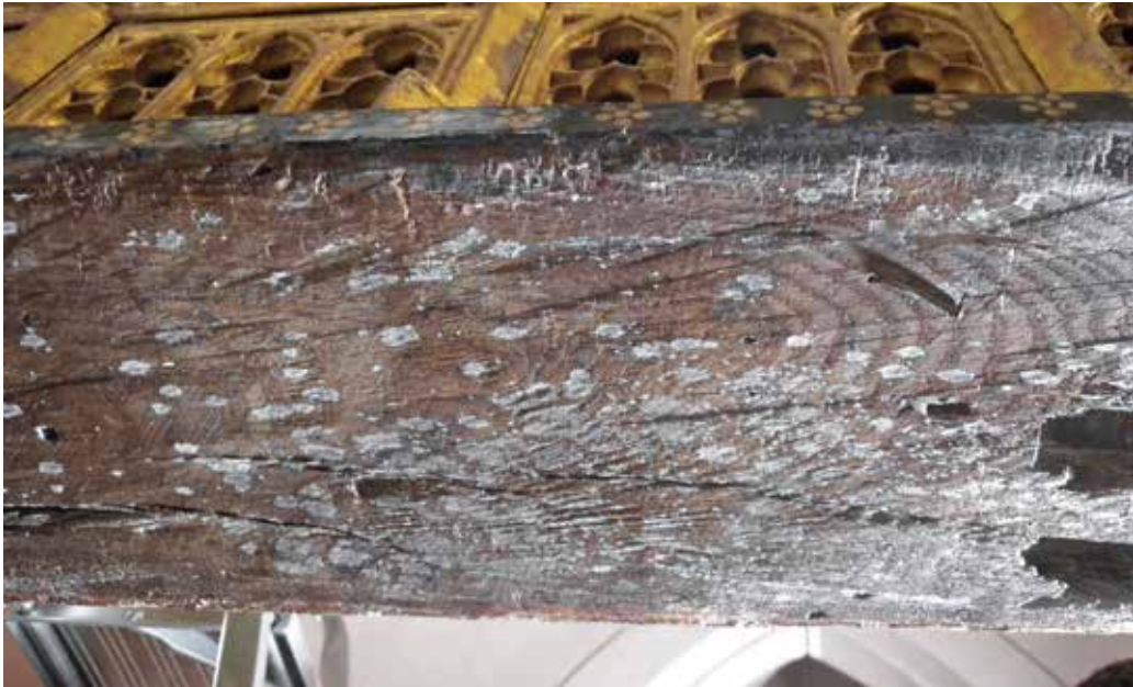
5. Altar, holzsichtige Unterseite mit Schimmelbelag. Foto: Martin Hammer, 2010.
