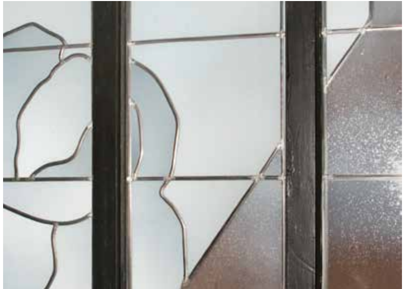
6. Leverkusen-Op-laden, St. Elisabeth. Detail Bleiverglasung mit Montageposition der Verglasung raumseitig im Fenster. Foto: Werner Schorlemer, LVR-ADR, 2010.
