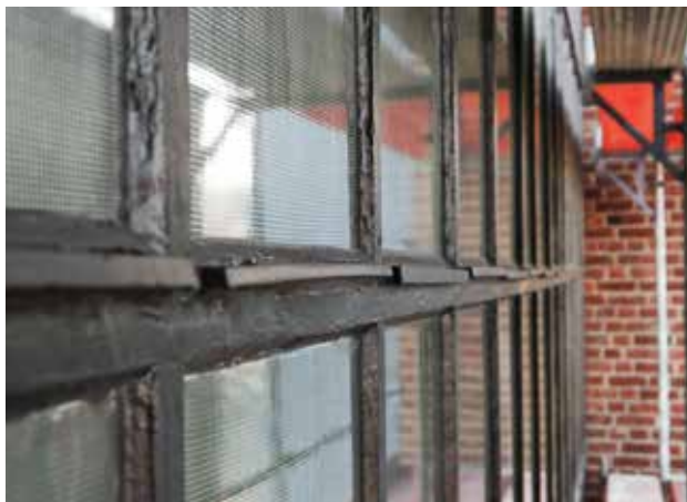
7. Leverkusen-Op-laden, St. Elisabeth. Detail der Fensterfront außen mit Verformung der Wasserschenkel. Foto: Werner Schorlemer, LVR-ADR, 2010.
