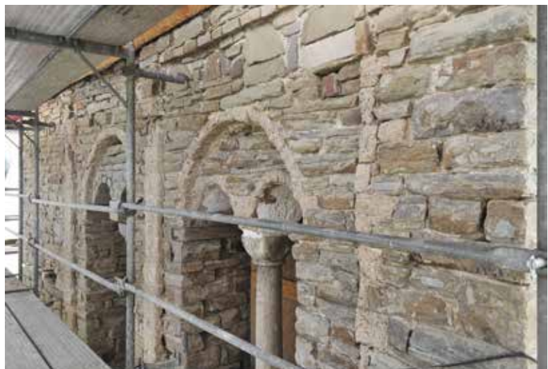
13. Engelskirchen, St. Peter und Paul. Turmobergeschoss nach der Entstehung des Putzes. Foto: Christoph Schaab, LVR-ADR, 2015.
