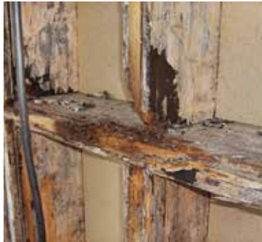
10. Leverkusen-Op-laden, St. Elisabeth. Detail eines massiven Holzfäulepilzschadens, der stellenweise bis ca. 15cm tief in die Substanz hinein reichte. Foto: Andreas Kokkinos, 2010.
