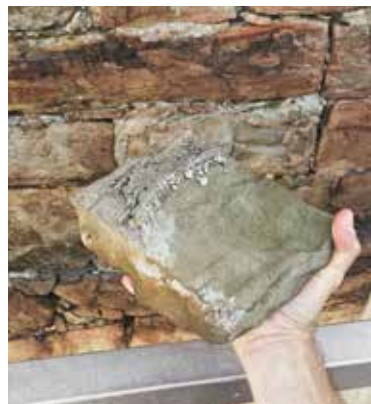
4./5. Wuppertal-Elberfeld, ev. Kirche am Kolk, Detail der Turmfassade und lockeres Material. Fotos: Christoph Schaab, LVR-ADR, 2016.
