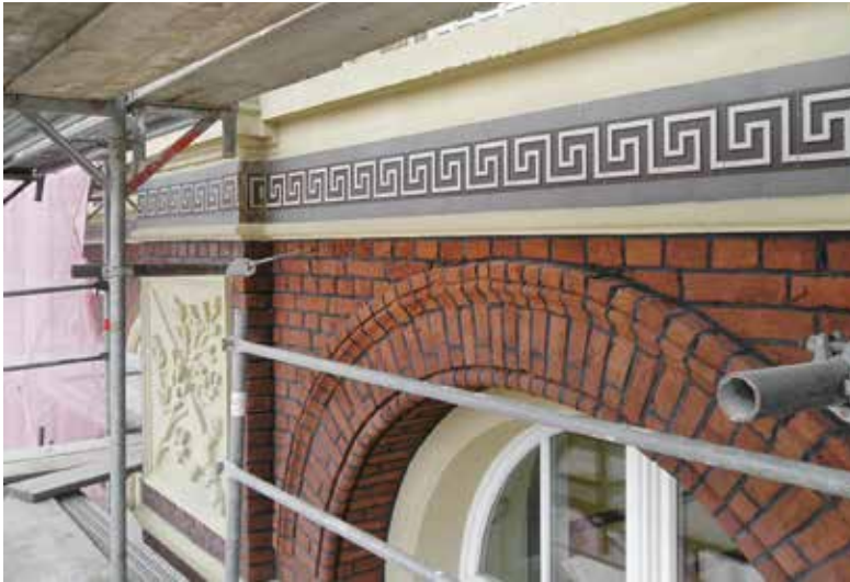
10. Duisburg, Land- und Amtsgericht. Erneuerung der Fugen. Foto: Christoph Schaab, LVR-ADR, 2010.
