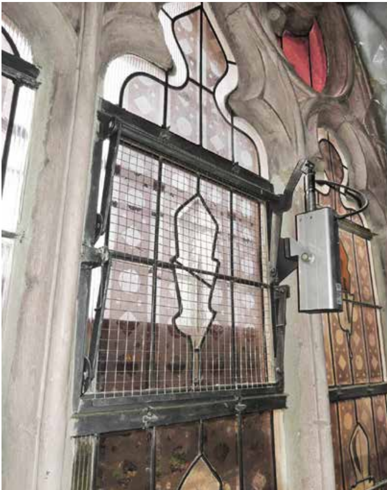
9. Zülpich-Bürvenich, Pfarrkirche Stephani Auffindung. Elektronisch gesteuerte Lüftungsvorrichtung am Fenster, automatisierte Regulierung abhängig von Innen- und Außenklima. Foto: Marc Peez, LVR-ADR, 2015.
