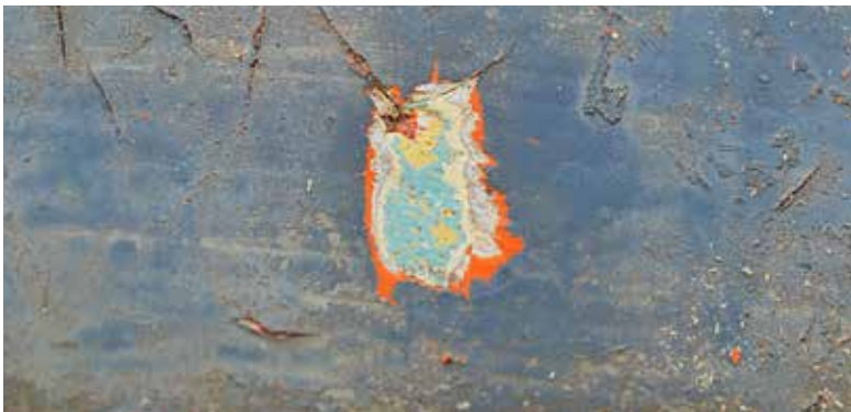
4. Augenklinik der Universitätskliniken Köln, Freilegungsprobe auf dem Geländer. Foto: Susanne Conrad, LVR-ADR.
