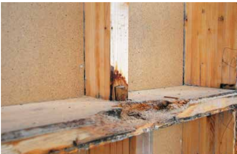
14. Leverkusen-Op-laden, St. Elisabeth. Detail der Fensterstruktur mit freigelegtem Holzdübel. Gut zu erkennen ist hier auch die Schutzverschalung vor der Bleiverglasung, die während der Arbeiten nicht ausgebaut wurde (die Bleiverglasung befindet sich hinter der Spanplatte). Foto: Kurt Weßel, 2010.
