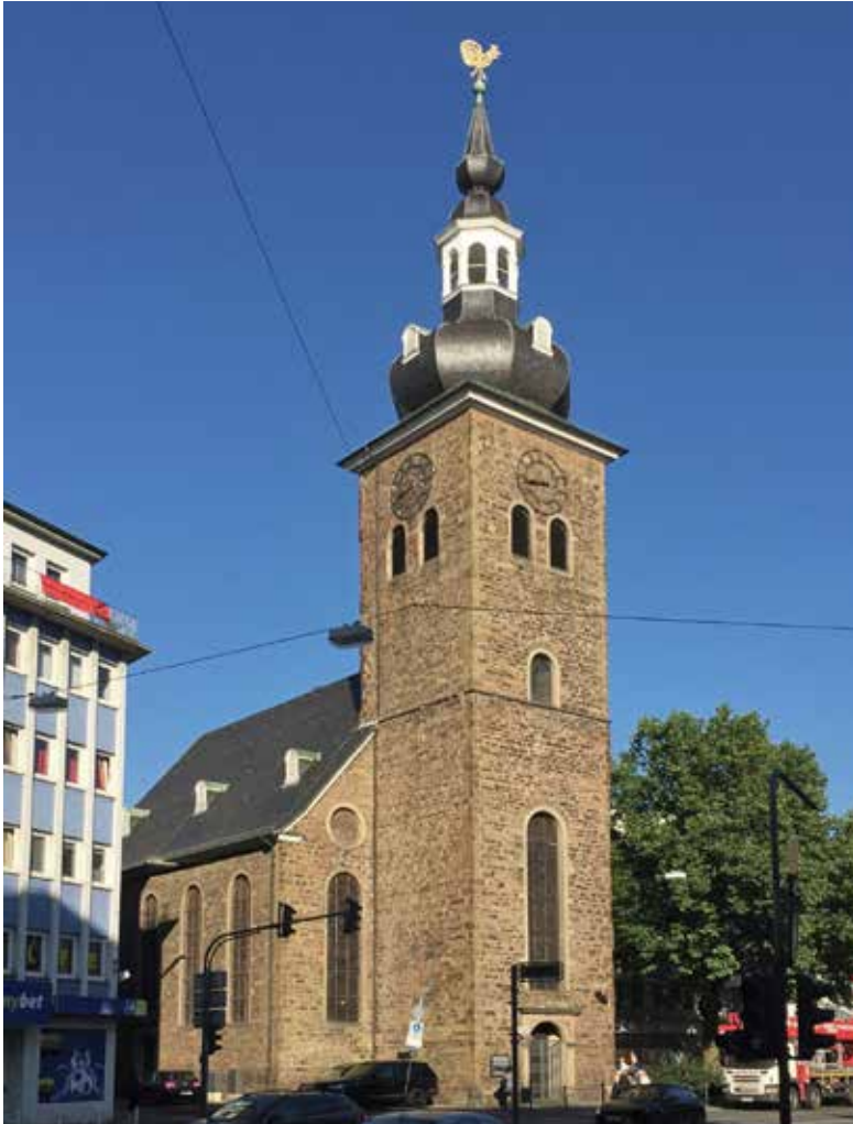
3. Wuppertal-Elberfeld, ev. Kirche am Kolk. Foto: Christoph Schaab, LVR-ADR, 2016.
