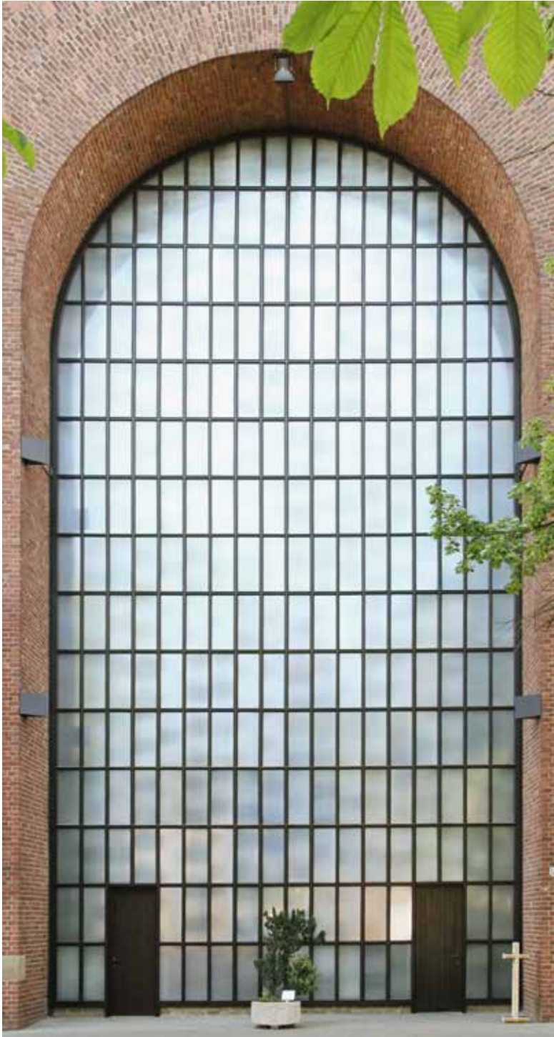
18. Leverkusen-Op- laden, St. Elisabeth. Ansicht des Fensters nach der Sanierung. Foto: Werner Schor- lemer, LVR-ADR, 2010.
