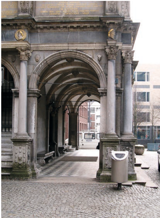
6. Köln, Altes Rathaus, Vorhalle, angeböschte Stufen. Foto: Ludger J. Sutthoff, LVR-ADR, 2005.
