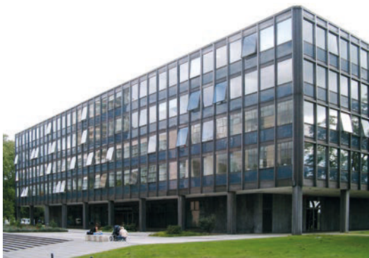
5. Köln, Landeshaus, Rampenanlage erleichtert den Zugang. Foto: Ludger J. Sutthoff, LVR-ADR, 2004.
