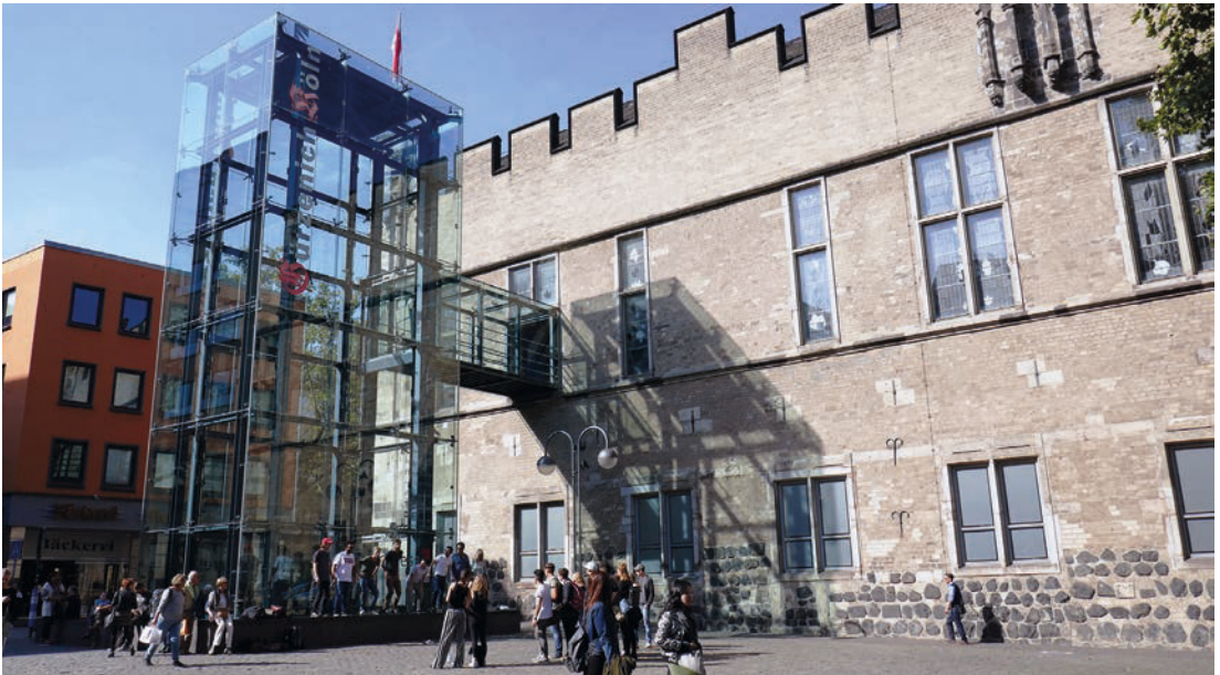
8. Köln, Gürzenich, Gläserner Aufzug überwindet Barrieren. Foto: Ludger J. Sutthoff, LVR-ADR, 2016.
