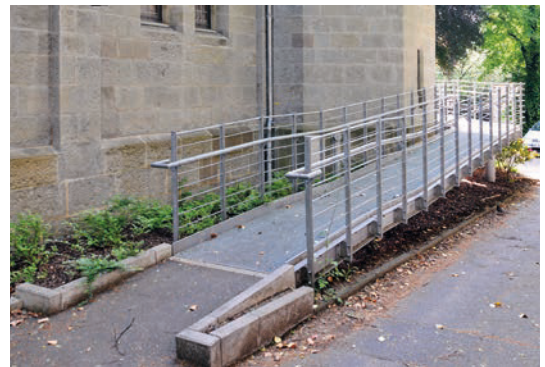
3. Wuppertal, Immanuelkirche/Kulturzentrum, von der Nordseite zum Westeingang herumgeführte Rampenanlage. Foto: Ludger J. Suthoff, LVR-ADR, 2011.
