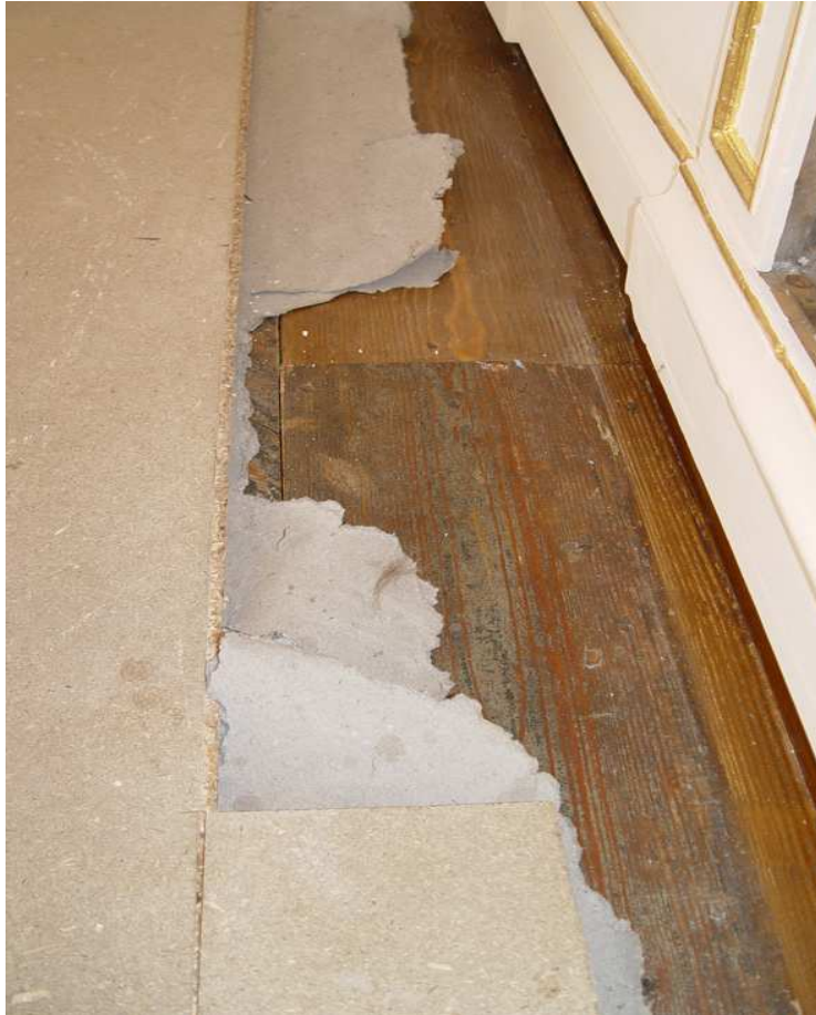
Burg Trips, Schutz des zuvor schon restaurierten Bodens
