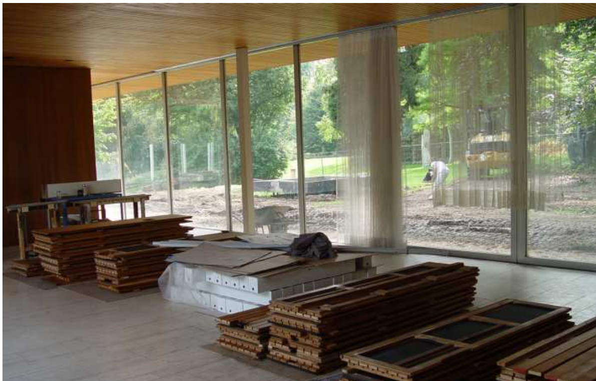
Bonn, Kanzlerbungalow, fachgerecht demontierte und zwischengelagerte Decke
