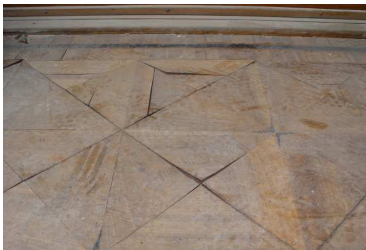
Feuchteschaden an einem nicht geschützten Holzfußboden
