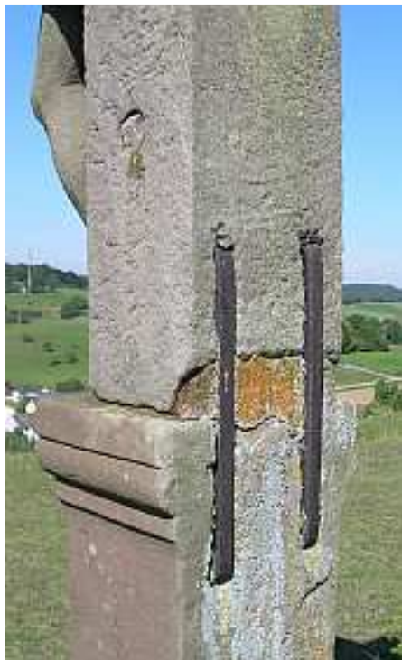
Geschmiedete Klammern in Bleiverguss an einem Kreuz des 17. Jahrhunderts, Blankenheim-Alendorf, 2005
