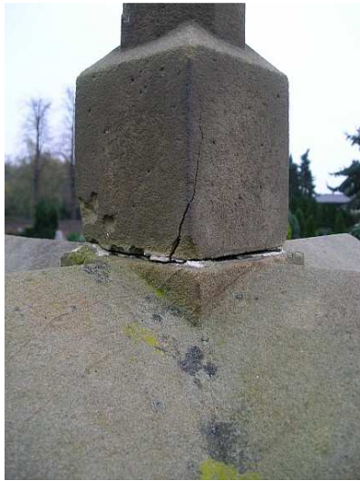
Durch rostende Eisenarmierung verursachte Rissbildung am Fuß eines Kreuzaufsatzes. Kamp-Lintfort, Kloster Kamp, Friedhof, 2009
