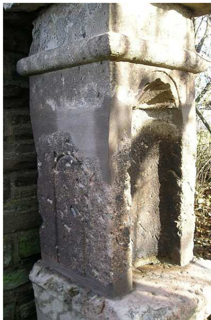
Mittelteil eines Wegekreuzes von 1683 aus Drachenfelder Trachyt, in der Mitte eine größere Restauriermörtelantragung. Hennef-Blankenberg, 2006
