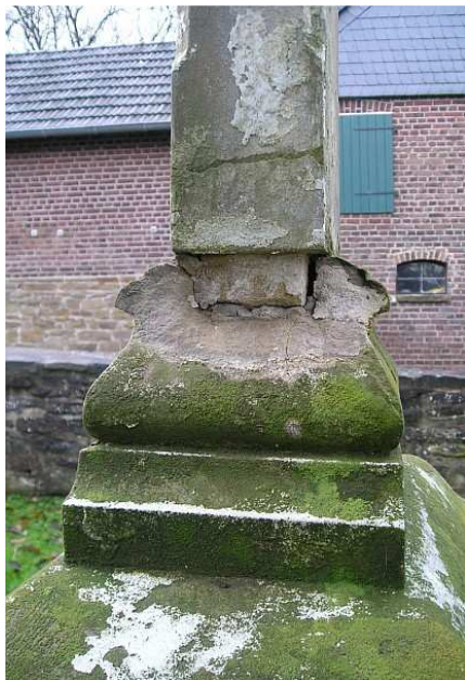
Durch Hebelwirkung einer Verzapfung aus Stein verursachte Rissbildungen und Ausplatzungen. Hennef-Bödingen, 2006
