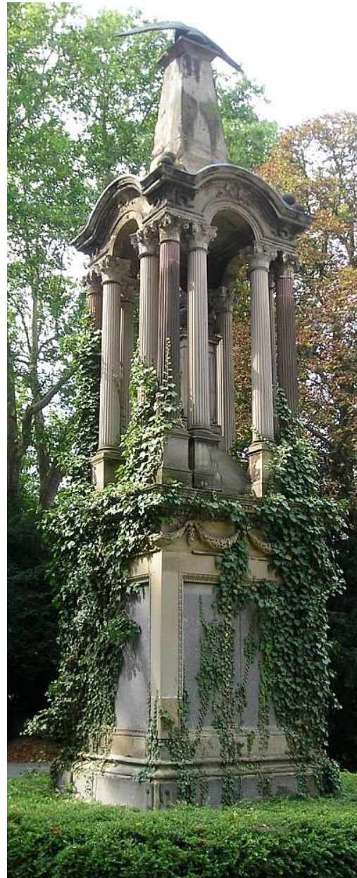
Efeubewuchs ist nur so lange „malerisch“, wie er nicht in Fugen eindringt oder bereits vorgeschädigte Steinsubstanz durch sein Eigengewicht abreißt. Köln, Friedhof Melaten, 2009
