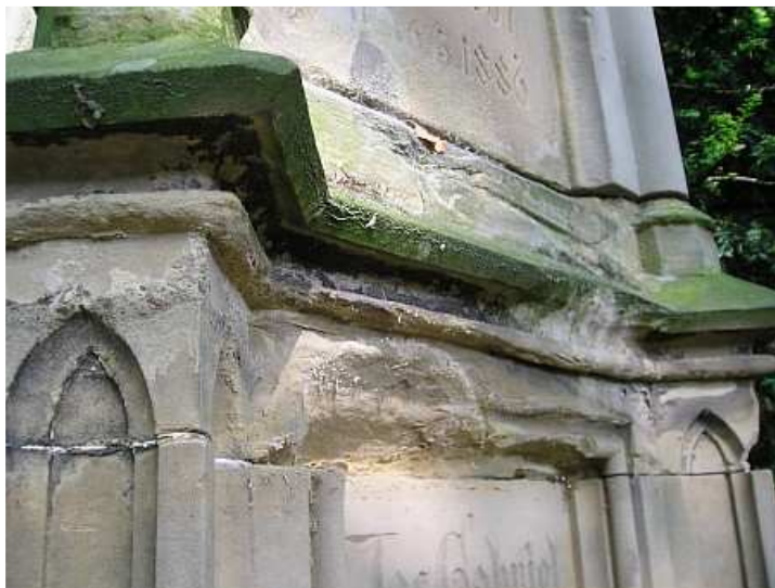
Infolge von Salzbelastung absandende Oberfläche an Heilbronner Sandstein. Köln, Friedhof Melaten, 2009
