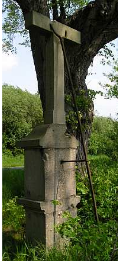
Schmiedeeiserne Stütze an einem Wegekreuz des 18. Jahrhunderts, Hennef, 2006
