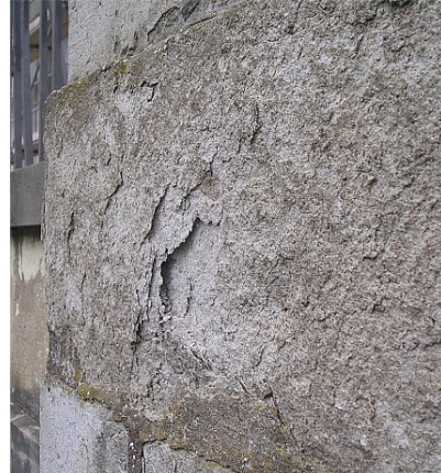
Abschuppende Oberfläche an Wolkenburger Andesit. Einfriedung von Schloss Falkenlust in Brühl, um 1730, 2004
