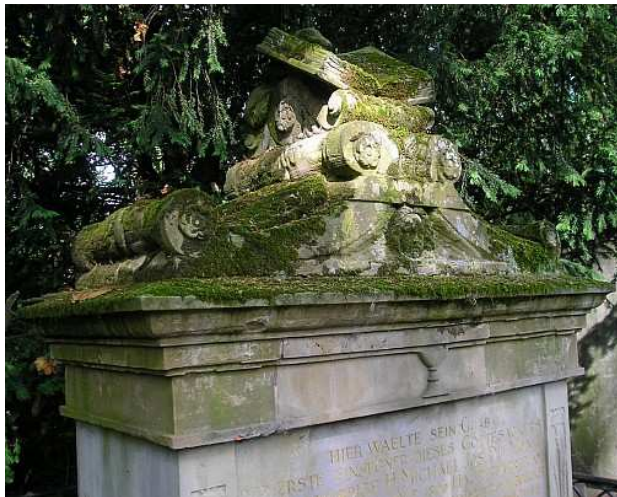
Starker Bewuchs mit Moos auf einer bildhauerisch gestalteten Abdeckung aus Sandstein kann Feuchtigkeit lange halten und kontinuierlich an das Steinmaterial abgeben. Köln, Friedhof Melaten, 2009
