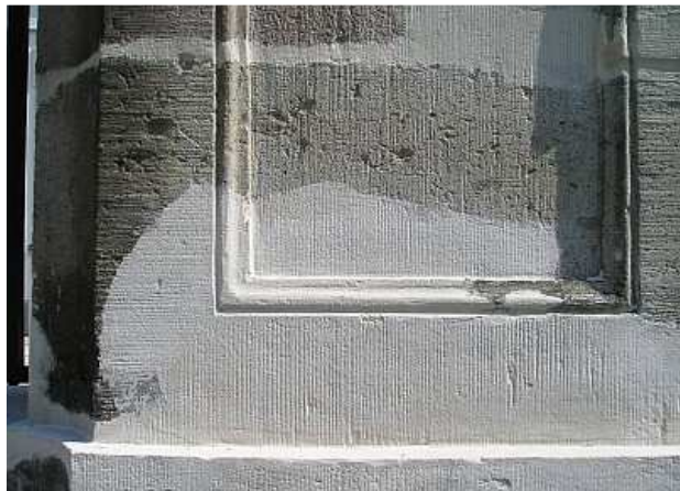
Restauriermörtelergänzung mit imitierter Steinbearbeitung an Wolkenburger Andesit. Einfriedung von Schloss Falkenlust in Brühl, um 1730, 2008
