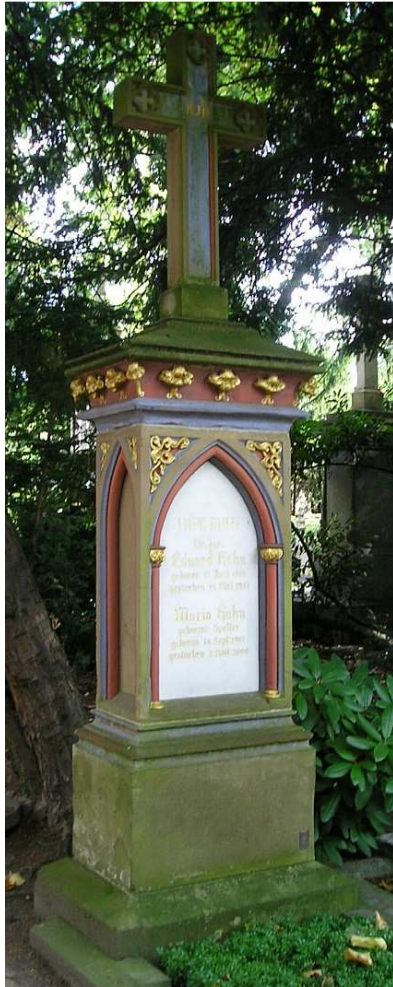
Grabmal aus Sandstein mit erneuerter Marmorplatte und Teilfassung in Mineralfarbe. Köln, Friedhof Melaten, 2009
