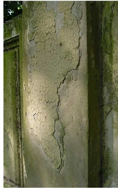
Reste eines mehrschichtigen Ölfarbanstriches auf einer Grabanlage aus Sandstein. Köln, Friedhof Melaten, 2009
