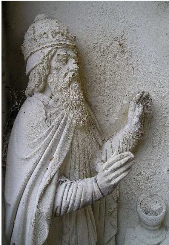
Rückwitterung durch Salzbelastung an Savonnières-Kalkstein. Hennef-Rott, 2006
