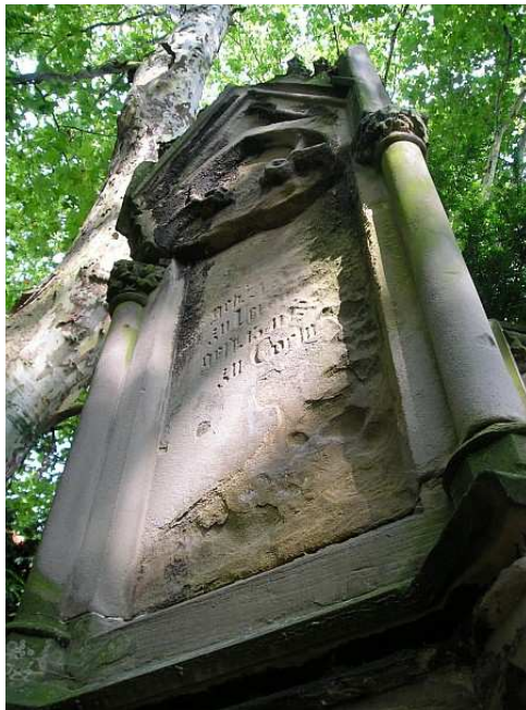
Alveolenförmige Auswitterungen und sandende Oberflächen an Heilbronner Sandstein. Köln, Friedhof Melaten, 2009
