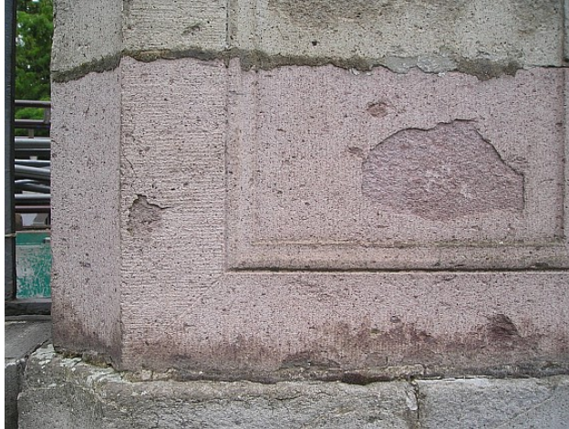
Schalenbildung an Wolkenburger Andesit. Einfriedung von Schloss Falkenlust in Brühl, um 1730. 2004
