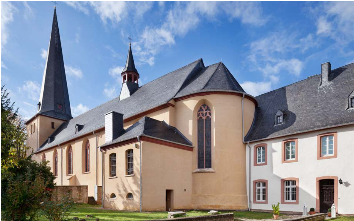
3. Bürvenich, Abschluss der Fassadensanierung 2014, Ansicht von Südosten. Foto: Vanessa Lange, LVR-ADR.
