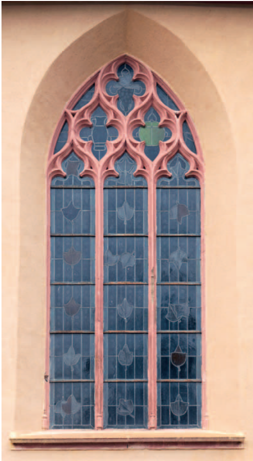
23. Maßwerkfenster der spätmittelalterlichen Bauerneuerung (1448). Entzerrtes Foto: Hans Meyer, LVR-ADR.
