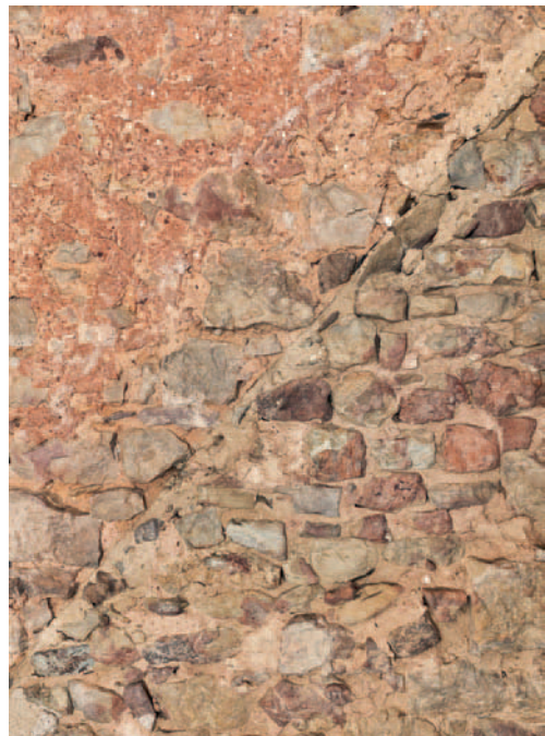
12. Vorgänger-/Profanbau, Dachanschlag (vgl. Abb.11 oben links). Foto: Viola Blumrich, LVR-ADR.
