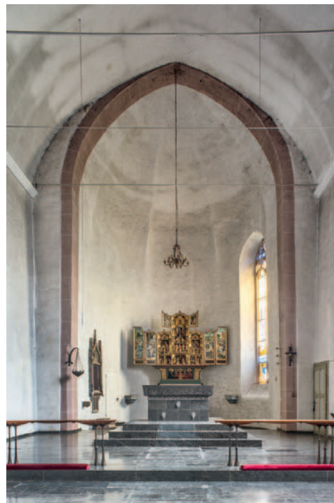
18. Nonnenkirche mit verputzter Holztonne, ehem. Lage des Nonnenchores. Foto: Jürgen Gregori, LVR-ADR.
