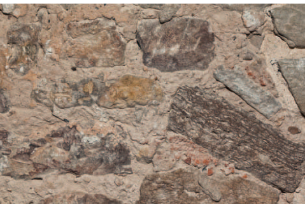
8. Mauerwerk der romanischen Pfarrkirche, bauzeitlicher Mauer- und Putzmörtel sowie Ziegelsplittputz an einem Fensterbogen. Foto: Viola Blumrich, LVR-ADR.
