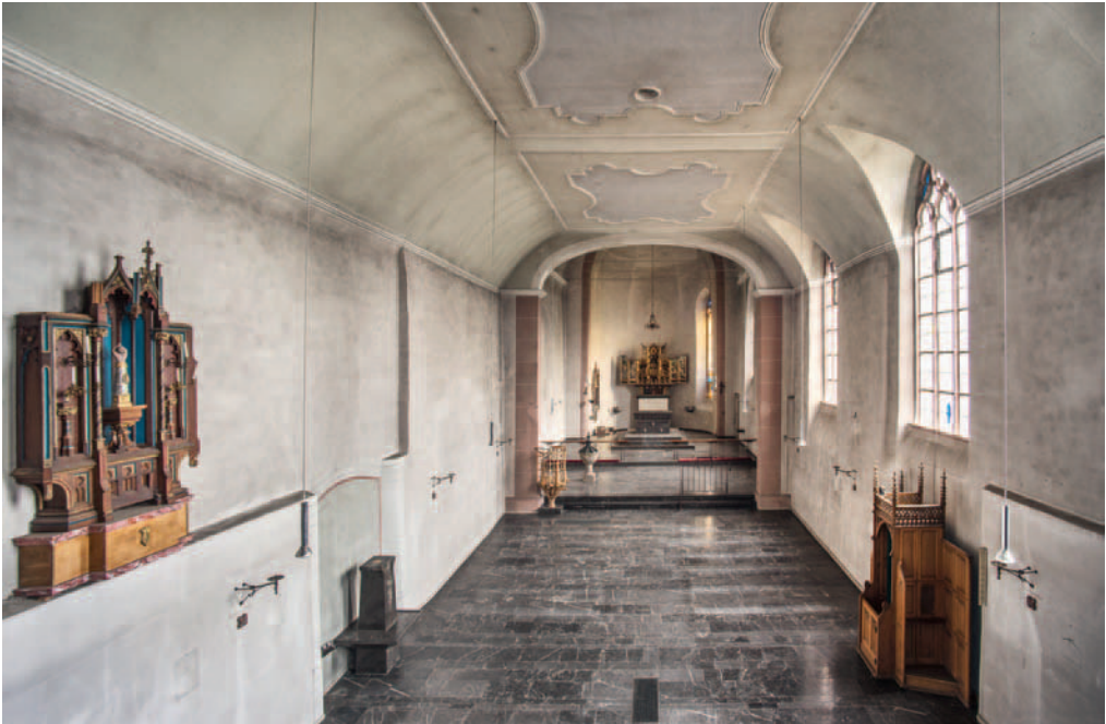
13. Kirchenschiff mit Wandvorsprung der romanischen Nonnenempore im Westteil, an deren Ende vertikale Baunaht zwischen Pfarr- und Nonnenkirche. Foto: Jürgen Gregori, LVR-ADR.
