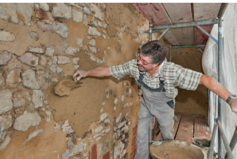
29. Anwurf des neuen Putzes auf der Nordseite, 2012. Foto: Viola Blumrich, LVR-ADR.
