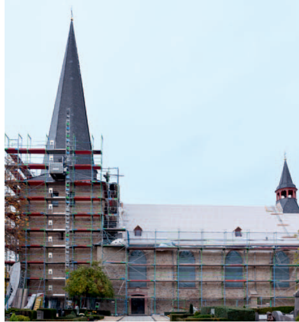
2. Bürvenich, Gesamtinstandsetzung seit 2011, Ansicht von Süden nach Abnahme des Außenputzes. Foto: Vanessa Lange, LVR-ADR.
