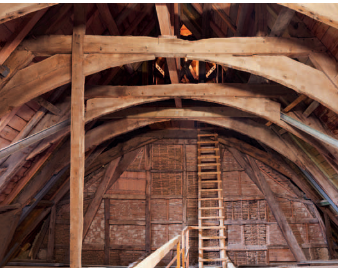
21. Dachwerk der Nonnenkirche, Holztonnenkonstruktion (1448 d), Fachwerkwand (1730 d). Foto: Vanessa Lange, LVR-ADR.
