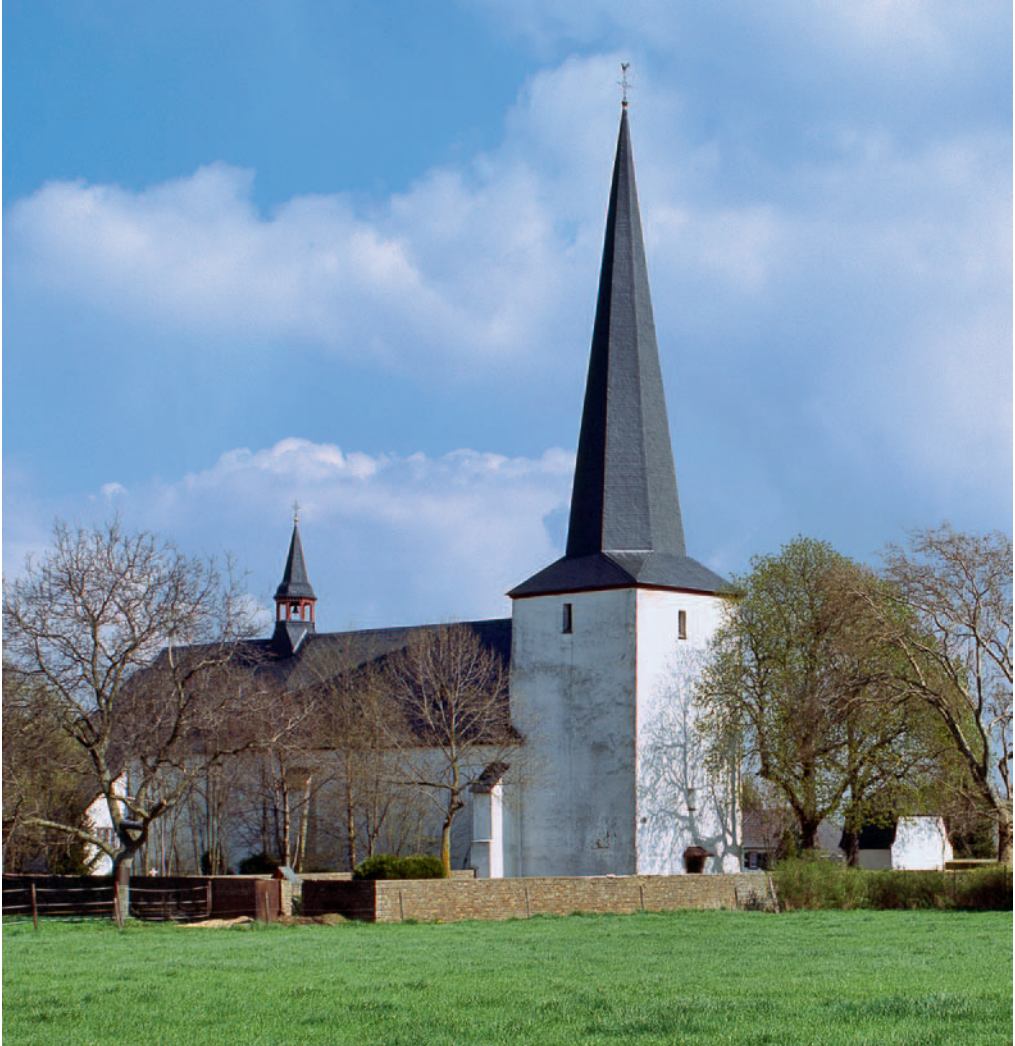
1. Bürvenich, Pfarr- und ehem. Zisterzienserinnenkirche, Ansicht von Nordwesten, Vorzustand, 2009. Foto: Jürgen Gregori, LVR-Amt für Denkmalpflege im Rheinland (LVR-ADR).
