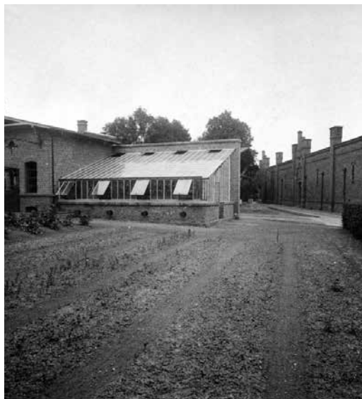
11. Gewächshaus und Schreinerei, ca. 1920 [Schreinerei erhalten]. Archiv des LVR, Bild 4/48 Aufnahme 15 [Treibhaus und Shedgebäude].
