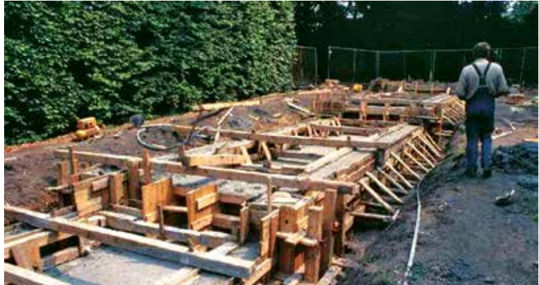
14. Neubau der Kaskade, 1987. Foto: Gerd Bermbach, Nümbrecht
