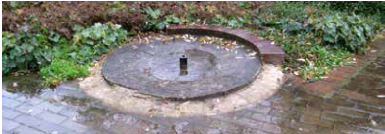
2. Detail in einer Parkanlage aus den 1950er/60er Jahren – Defekter Brunnen. Foto: Almuth Spelberg.
