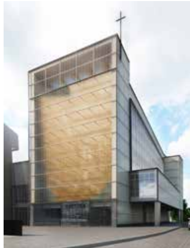
5. Duisburg, Liebfrauenkirche. Modell der geplanten transluzenten Hülle aus mehrschichtigen Polycarbonatplatten. Fondation Kybernetik der TU Darmstadt.
