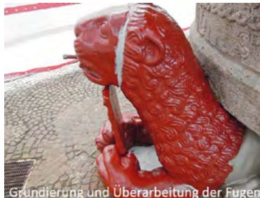
Grundierung und Überarbeitung der Fugen
