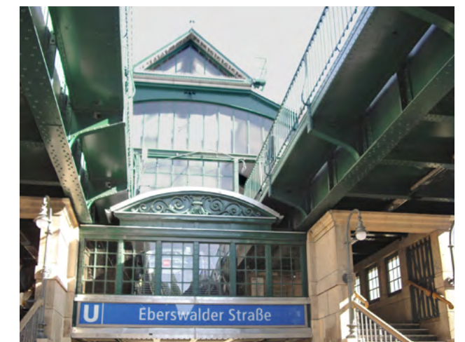
15. Aufgang zum Bahnhof Eberswalder Straße nach der Sanierung. Foto: Lorenz & Co. Bauingenieure.
