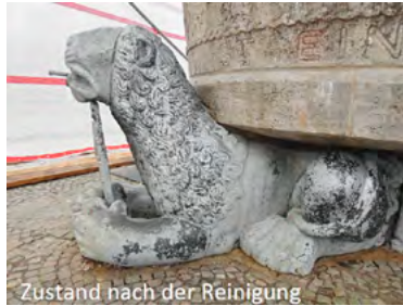
Zustand nach der Reinigung
