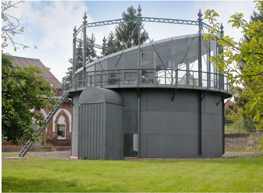
14. Gasometer Moringen. Photovoltaikdach nach Sanierung. Foto: Hempel Ingenieure, Köln.
