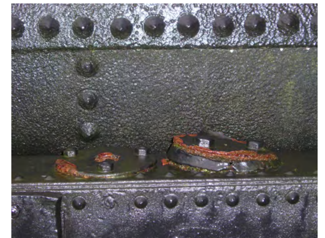
5. Typischer Korrosionsschaden an einer Feuchtigkeitssammelstelle. Foto: Susanne Conrad, LVR-ADR.
