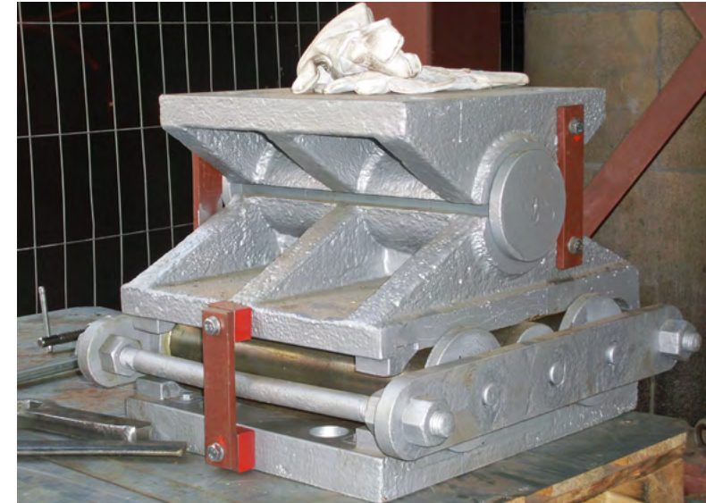
6. Überarbeiteter Lagerkörper mit erneuerten Rollen und Zapfen vor dem Wiedereinbau. Foto: Lorenz & Co. Bauingenieure.
