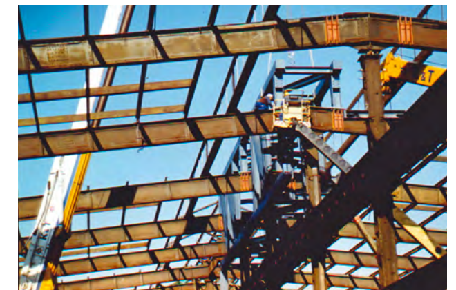
3. Lokhalle Göttingen, Montage der räumlichen Fachwerkträger. Foto: Hempel Ingenieure, Köln
