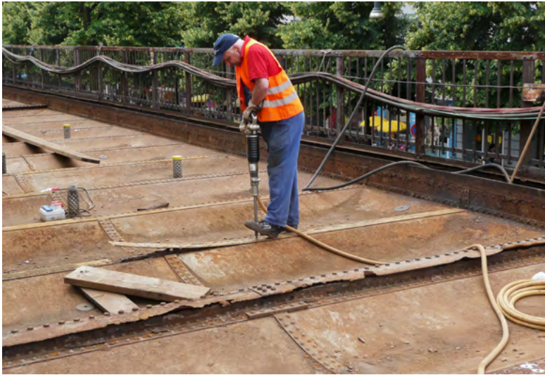
12. Demontage der Fahrbahnbleche, erkennbar die Korrosions- schäden am Querträger-Auflager. Foto: Lorenz & Co. Bauingenieure.
