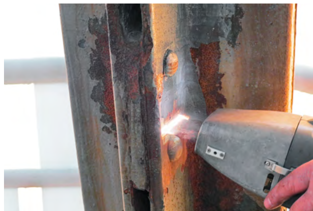
9. Kugelwasserturm IIsede. Entschichtung und Abreinigung mit Hilfe des Lasers. Foto: Hempel Ingenieure, Köln.
