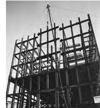
5. Gerling Hochhaus, Köln. Montage der historischen Stahlkonstruktion. Archiv Hempel Ingenieure, Köln.
