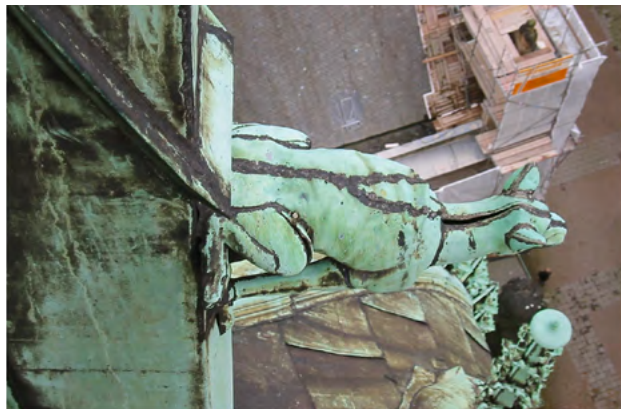
3. Krefeld, St. Dionysius. Schadensdokumentation. Fotos: J & P Johanning und Petermann Architekten.
