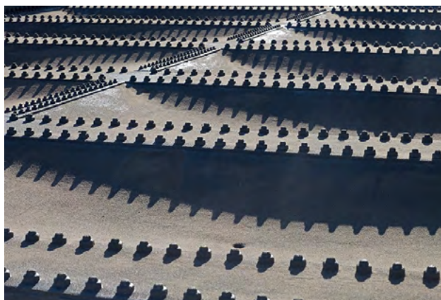
13. Erneuerte Buckelbleche, Schrauben statt Niete, vor Aufbringen des Schotterbetts. Foto: Lorenz & Co. Bauingenieure.
