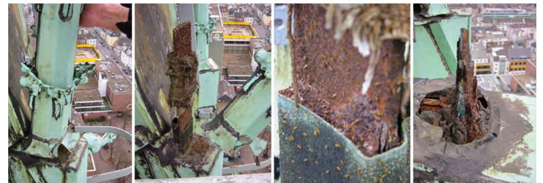
5. Krefeld, St. Dionysius. Schadensdokumentation. Fotos: J & P Johanning und Petermann Architekten.
