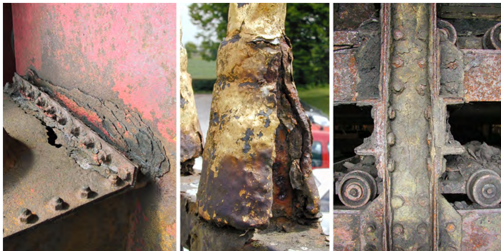
1. Eisen rostet. Fotos: Susanne Conrad, LVR-Amt für Denkmalpflege im Rheinland (LVR-ADR).
