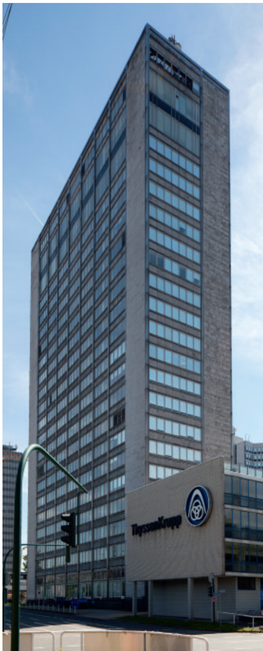
8. Ansicht von Nordosten, Hochhaus und Verwaltungsgebäude gerahmt von der Hochhaussilhouette, Foto: Jessica Blank, LVR-ADR, 2014.
