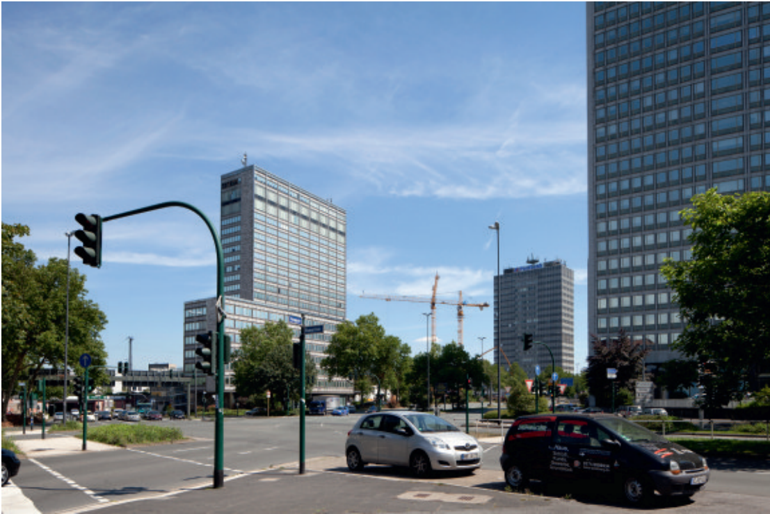
5. Ansicht von Südwesten, im Hintergrund ist das Postcheckamt und gegenüber das RWE-Hochhaus zu sehen, hier wird das Konzept des Hochhausgürtels um Essen besonders anschaulich, Foto: Jessica Blank, LVR-ADR, 2014.
