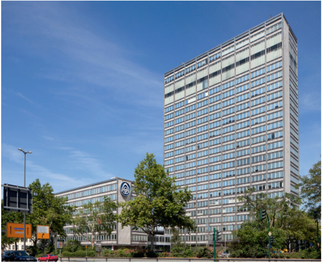
2. Ansicht von Südosten, Foto: Jessica Blank LVR-ADR 2014.
