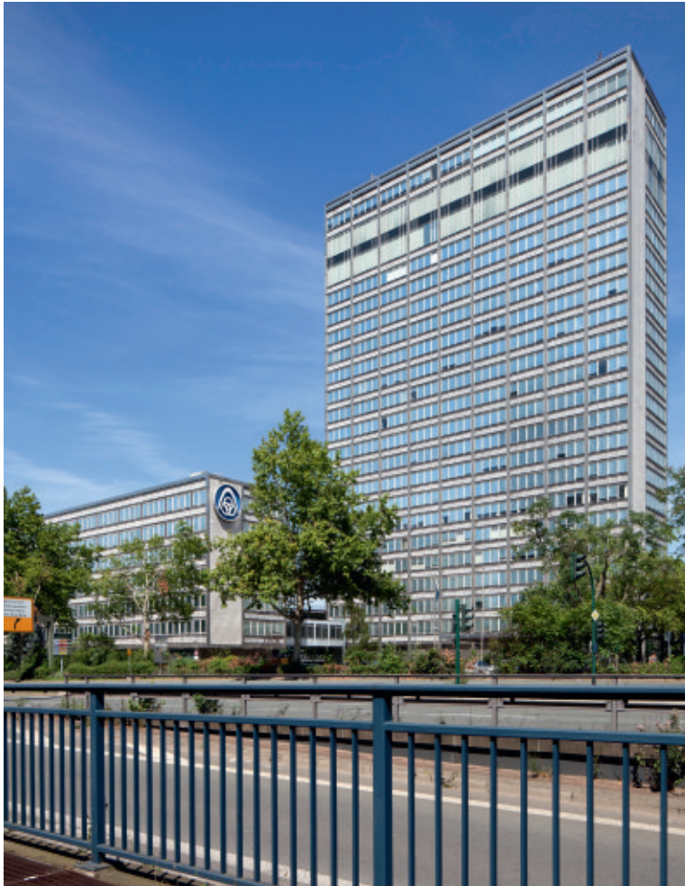
4. Ansicht von Süden, Foto: Jessica Blank, LVR-ADR, 2014.
