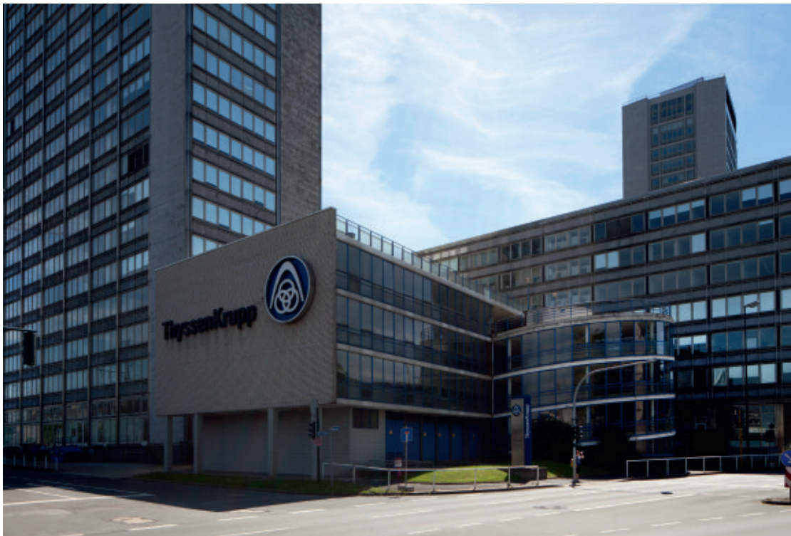
6. Ansicht von Nordwesten, Parkgarage mit markant vorkragender Wendelrampe, Foto: Jessica Blank, LVR-ADR, 2014.
