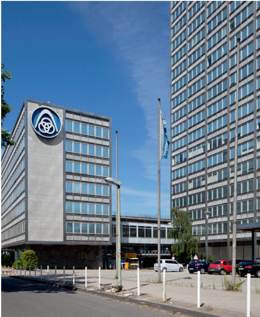
7. Blick auf das Verwaltungsgebäude und die verbindende Brücke zum Hochhaus, Foto: Jessica Blank, LVR-ADR, 2014.
