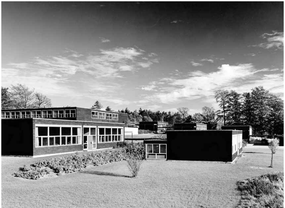
6. Volksschule Radevormwald (1963–1965), Ansicht von Westen, Foto: Archiv B.+C. Lambart Architekten, Ratingen.
