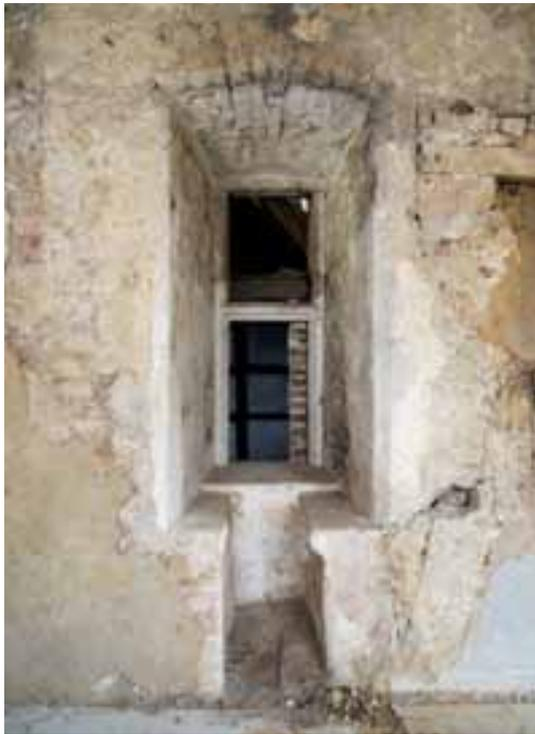
9. Fundstelle Sitznischenfenster, Turmzimmer Ostseite. Das Fenster war bis zur Sanierung 2008 zum Innenraum wandbündig vermauert. Das Oberlicht öffnet sich in den Dachstuhl des 1708 errichteten Ostflügels, das jüngst geöffnete Unterlicht in das Treppenhaus. Foto: Jann Höfer, LVR-ADR, 2009
