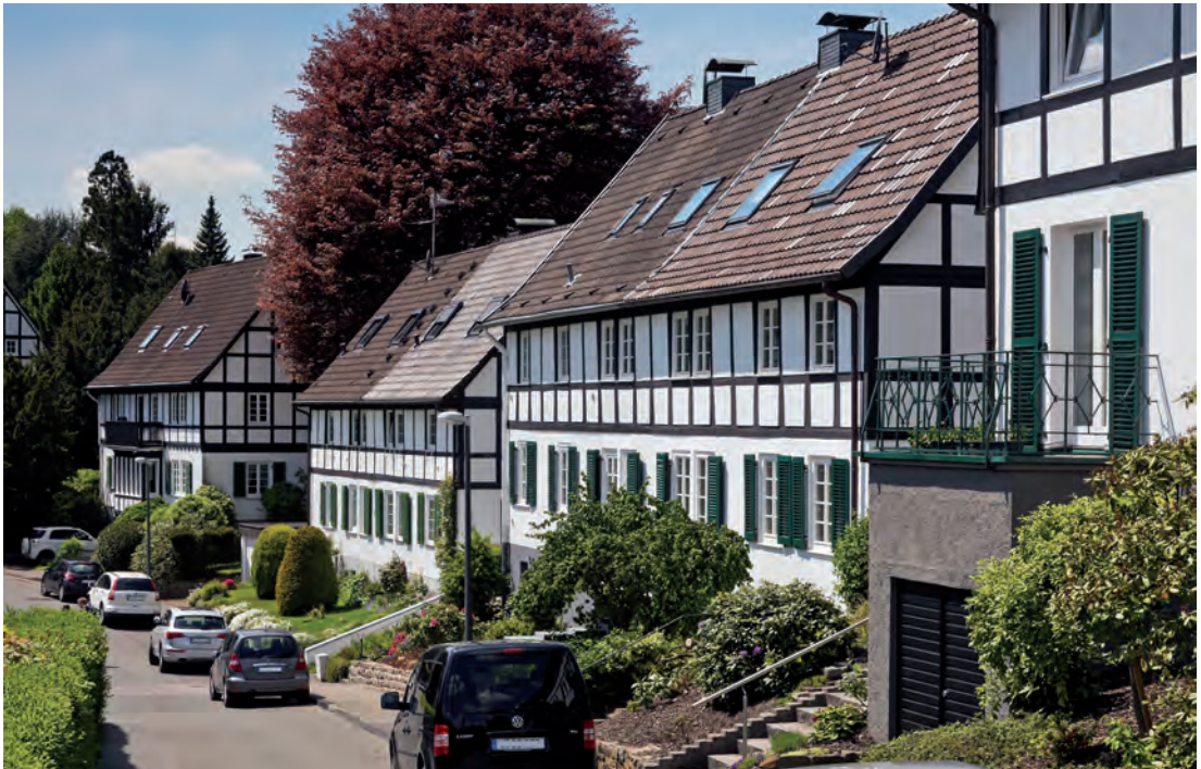
6. Wuppertal, Lotte-Naumann-Siedlung. Foto: Viola Blumrich, LVR-ADR, 2017.
