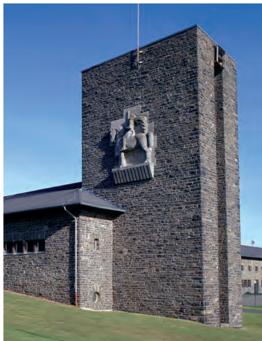
2. Schleiden, ehem. Ordensburg Vogelsang, Eingangsbereich Ostturm. Foto: Jürgen Gregori, LVR-ADR, 2002.
