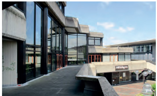
9. Krefeld, Stadthalle, sog. Seidenweberhaus. Foto: Sven Kuhrau, LVR-ADR, 2016.
