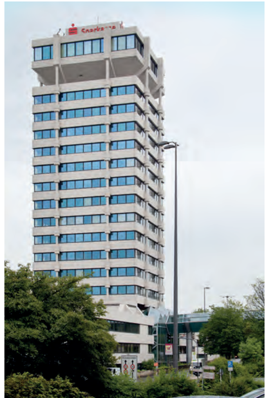
10. Wuppertal-Elberfeld, Sparkassenhochhaus, (1969–73). Foto: Silvia Margrit Wolf, LVR-ADR, 2014.
